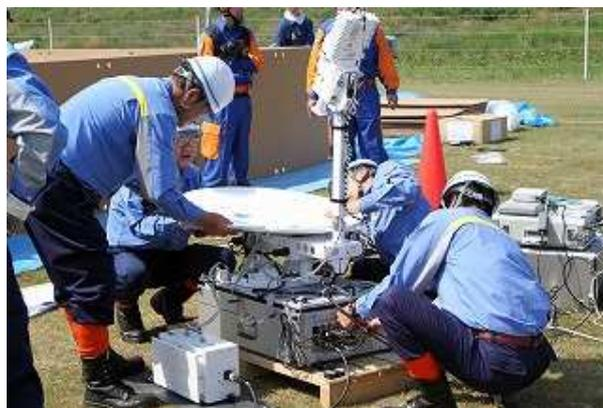
小型ポータブル衛星装置の設置訓練
