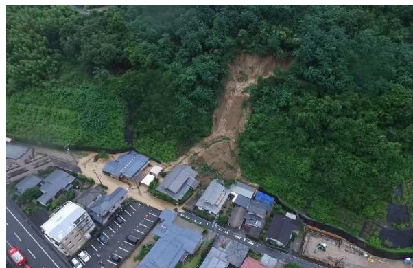
屋島で発生した土砂災害（H30年7月豪雨） 香川県提供
