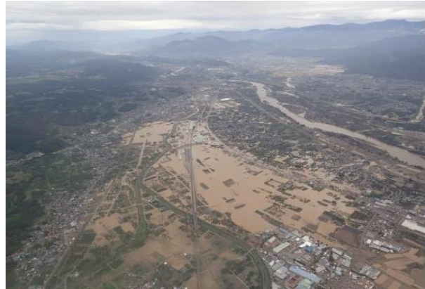
千曲川堤防決壊による浸水状況 北陸地方整備局提供
