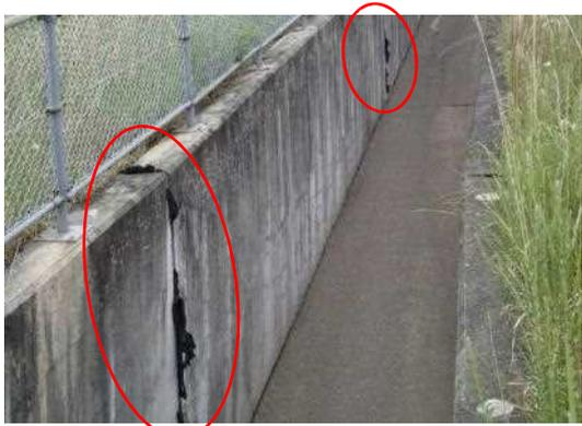
写真IV-2-9 参考:アルカリ骨材反応の
