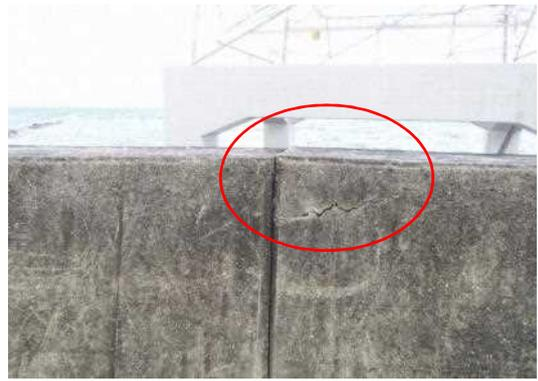
写真IV-2-10 参考:アルカリ骨材反応の
