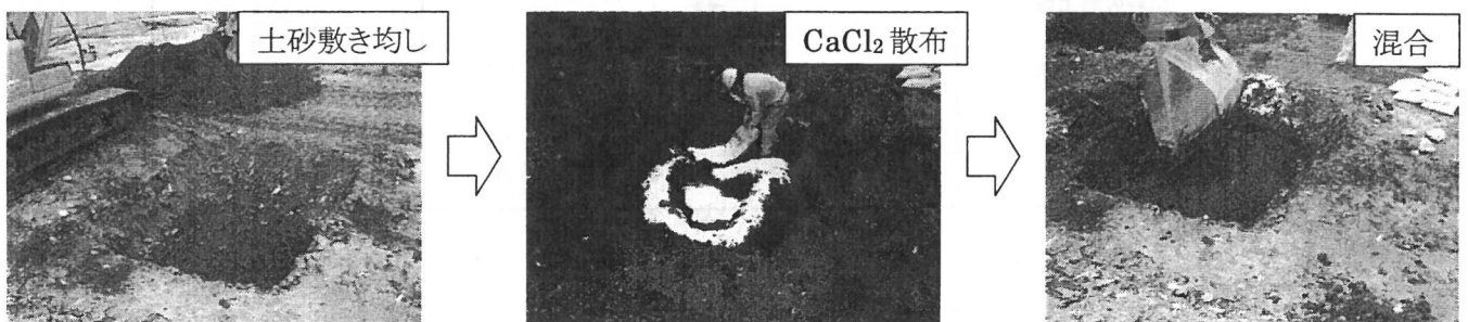
図 3-2 塩化カルシウムの混合風景
