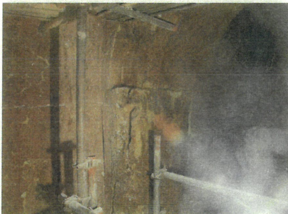
(5) 後燃焼室煙道側壁 (補修前)
