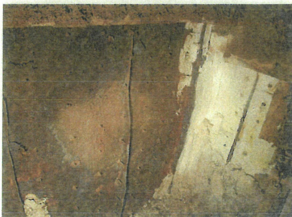
(7) 後燃焼室上部 (ケーシング補修前)
