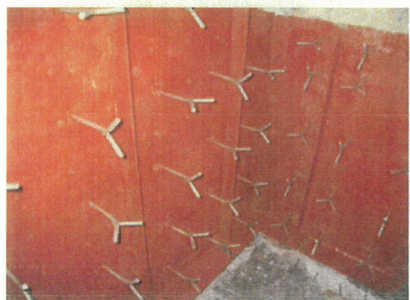
(8) 後燃焼室上部 (ケーシング補修後)
