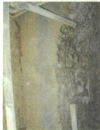
(6) 後燃焼室煙道側壁 (簡易補修後)
