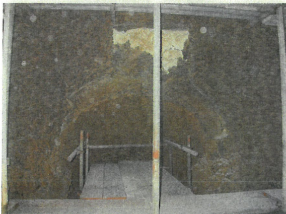
(3) 二次燃焼室煙道周辺 (補修前)
