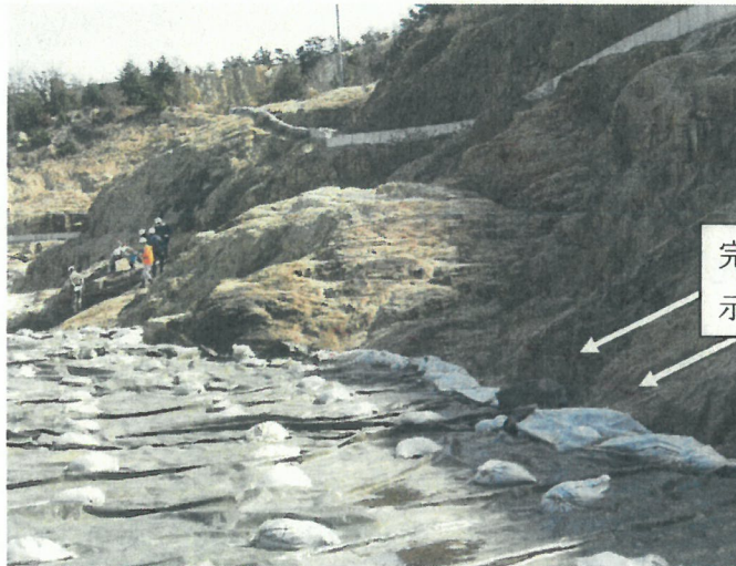
写真1 掘削完了判定調査 処分地南斜面(H21. 3. 12)
