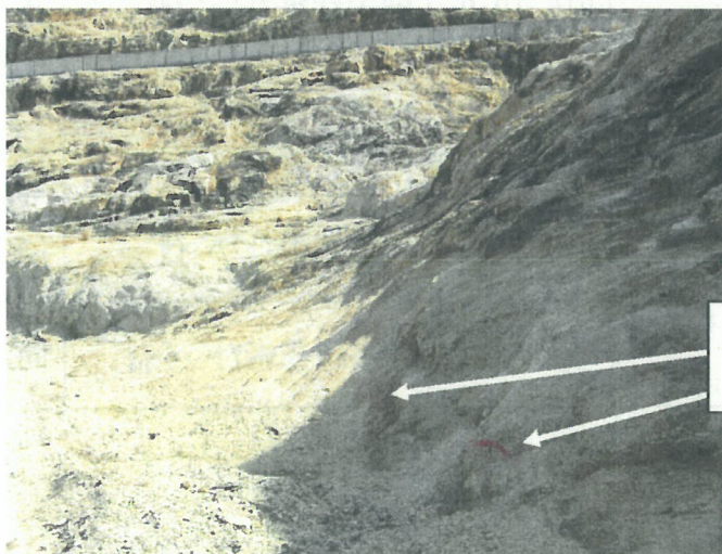
写真3 完了判定調査処分地南東斜面
