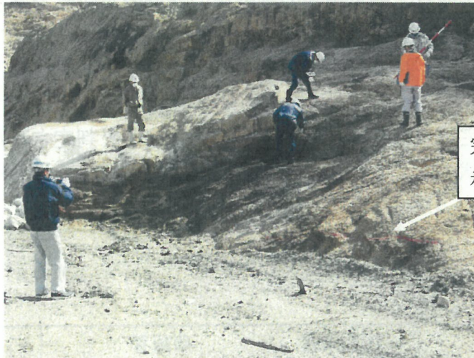
写真2 掘削完了判定調査処分地南斜面(H21. 3. 12)
