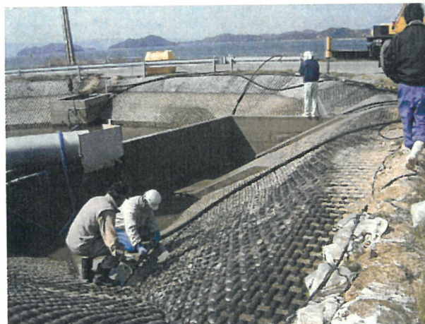
写真4 初期雨水貯留槽清掃
