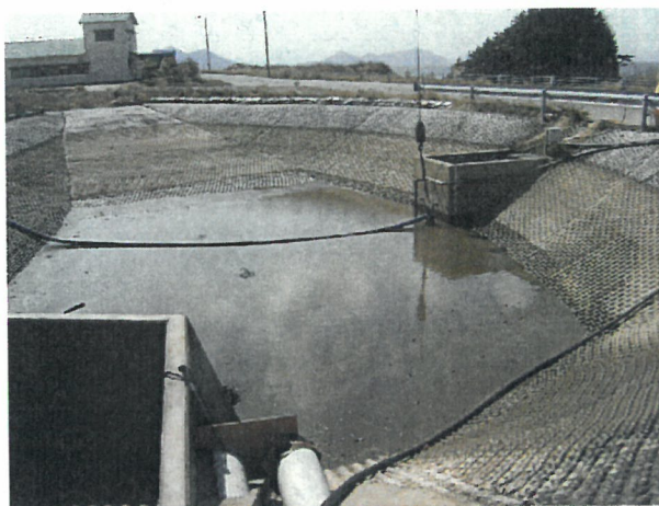
写真2 沈砂池2清掃
