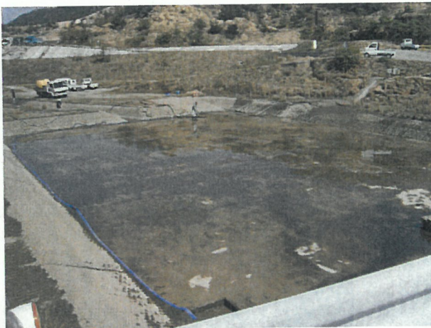
写真14 沈砂池1 清掃後
