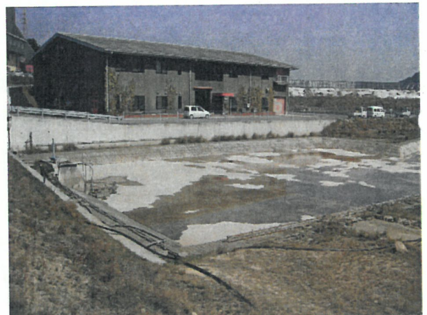
写真15 沈砂池1 清掃後
