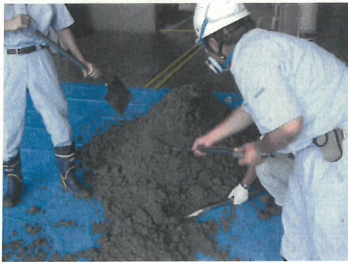
図15 均質化作業状況
