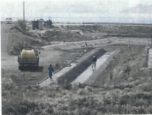
写真11 沈砂池1 清掃
