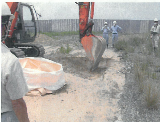
図13 EF3覆土掘削状況
