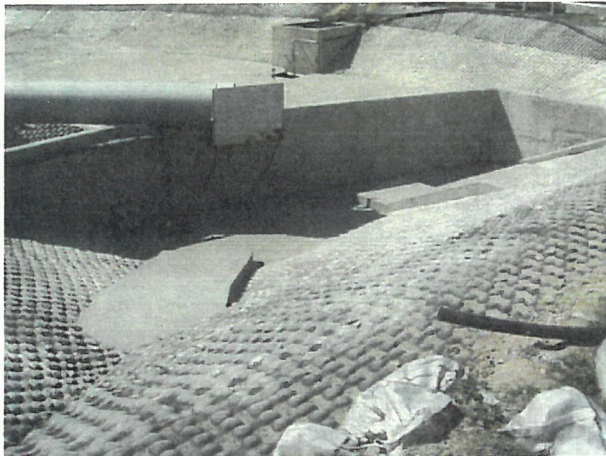
写真5 初期雨水貯留槽清掃後
