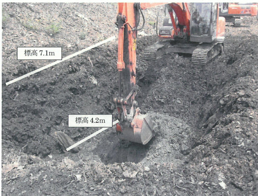
図8 HI-2地点直下土壌採取状況
