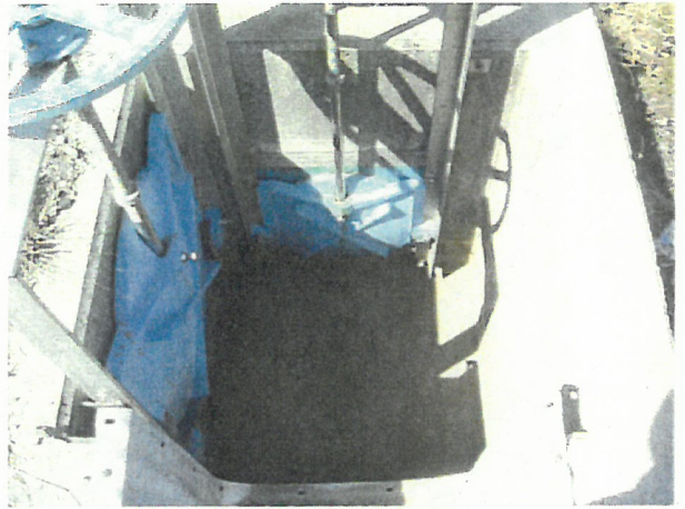
写真8 切替水門清掃後
