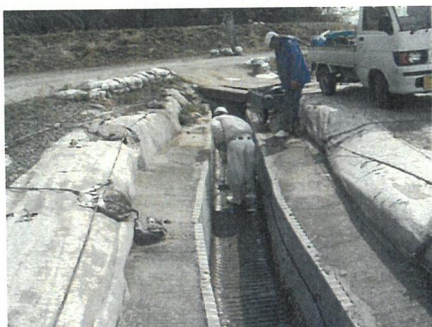
写真1 第4工区雨水排水路清掃
