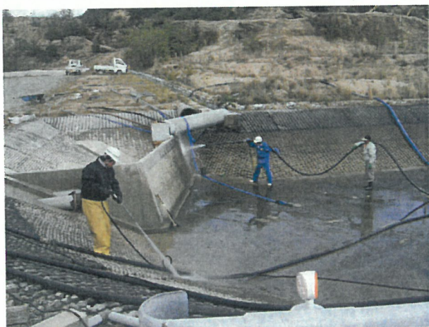
写真3 沈砂池2清掃
