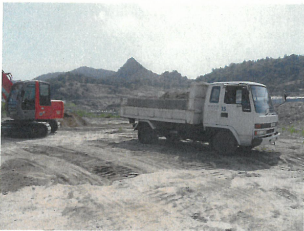
覆土運搬状況(B区域)
