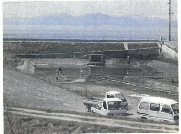
写真12 沈砂池1 清掃
