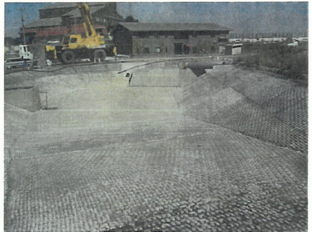
写真6 沈砂池2清掃後
