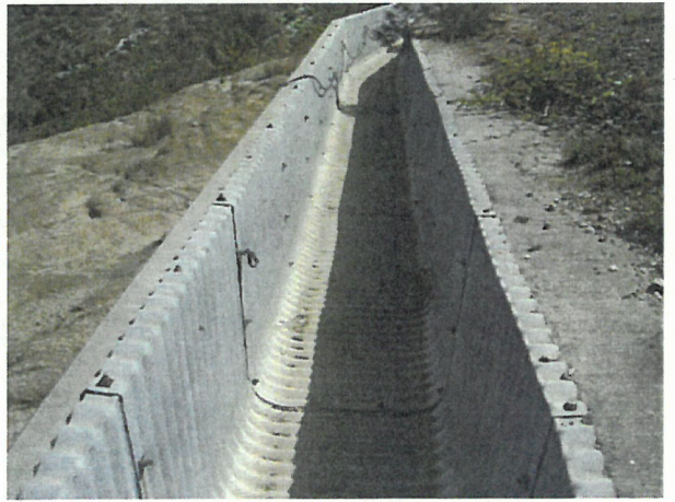
写真10 第4工区雨水排水路清掃後
