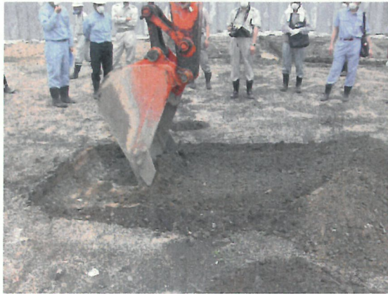
図11 CD2覆土掘削状況
