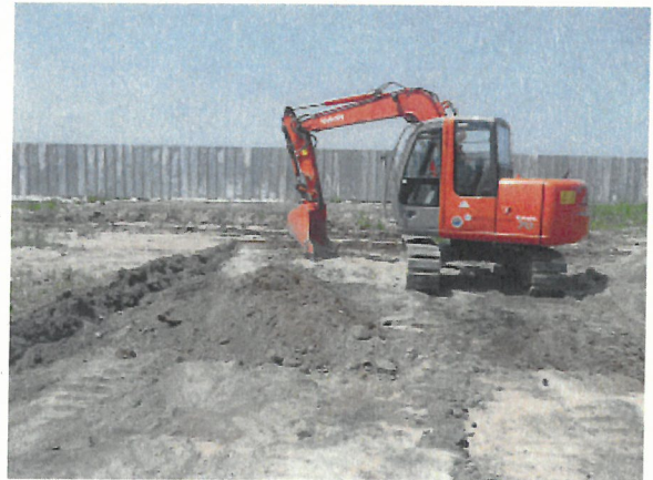
覆土掘削状況(B区域)
