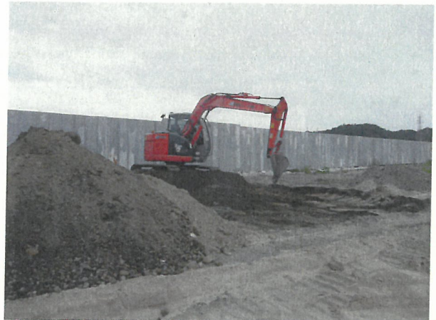
覆土掘削状況(A区域)
