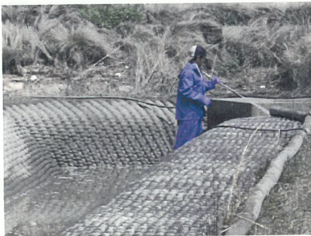
写真13 沈砂池1 清掃
