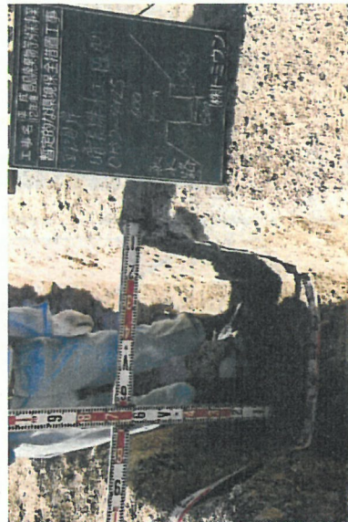
写真7 南北暗渠排水工施工の様子
