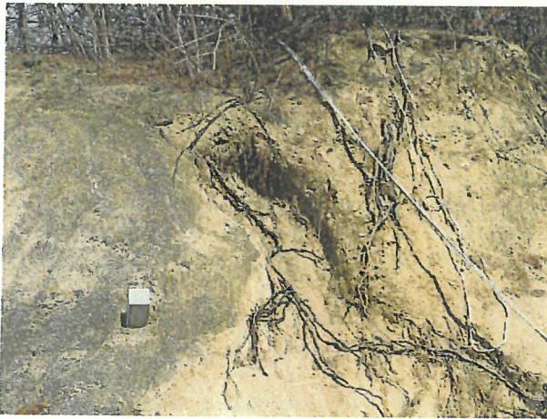
写真6 廃棄物除去作業 (H23.1.6) : 除去後
