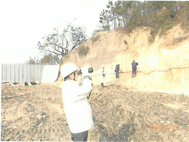
写真1 掘削完了判定調査 (H22.12.24)
