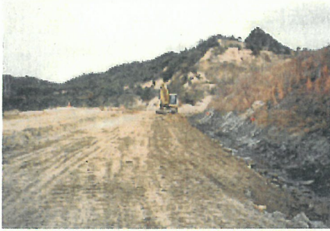
写真-1 廃棄物掘削・除去状況
