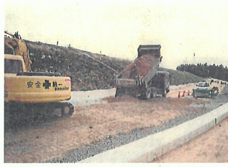
写真-2 埋戻し状況
