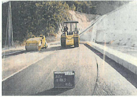
写真-4 アスファルト施工状況
