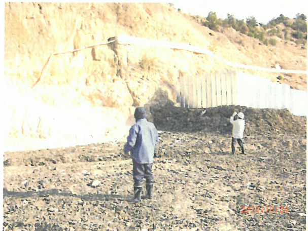
写真2 掘削完了判定調査 (H22.12.24)
