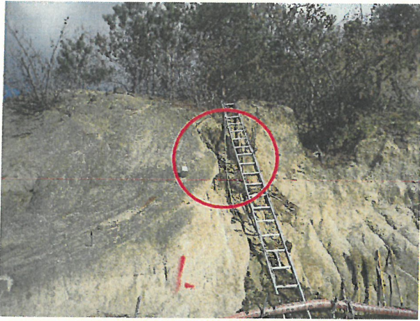
写真4 廃棄物除去作業 (H23.1.6) : 除去前
