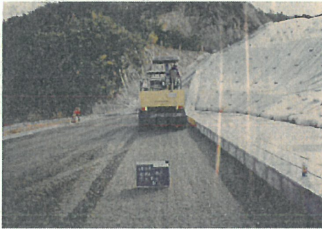
写真-3 粒調碎石施工状況
