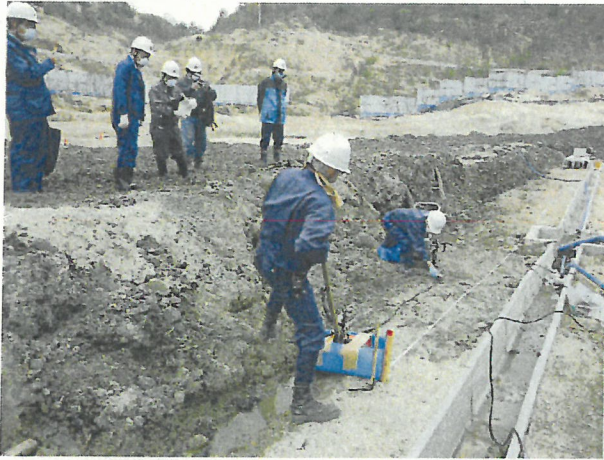
写真8 SITE-1 地下レーダ探査
