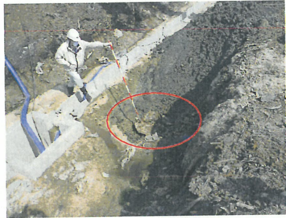
写真2 ドラム缶埋設状況
