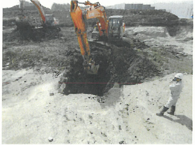
写真 2 B地点(製紙汚泥等掘削状況)
