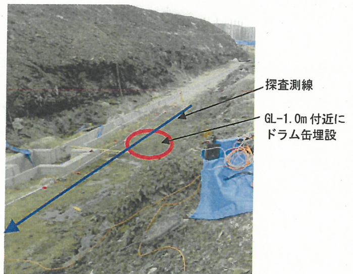
写真3 SITE-1 探査実施場所
