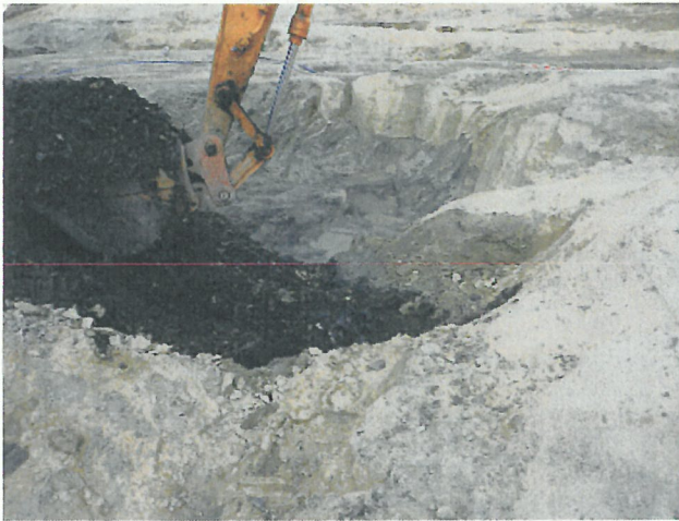
写真7 E地点(シュレッダーダスト掘削状況)
