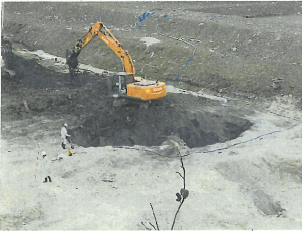
写真 3 C地点(シュレッダーダスト掘削状況)
