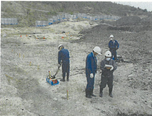
写真10 SITE-2 地下レーダ探査
