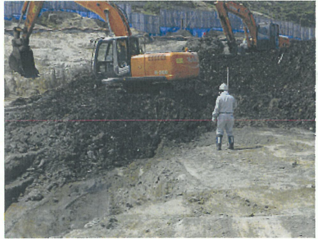
写真8 F地点(シュレッダーダスト掘削状況)
