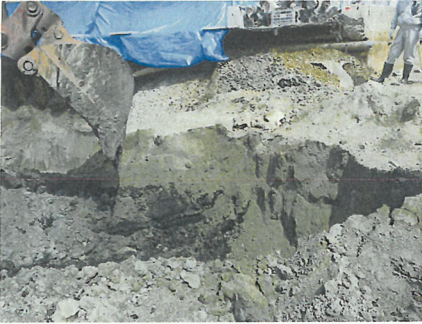
写真 1 A地点(製紙汚泥等掘削状況)
