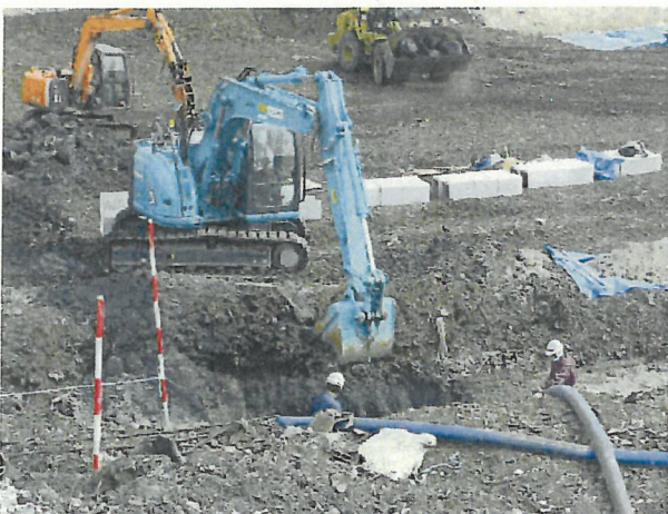
写真 5 D地点(ドラム缶掘削状況)
