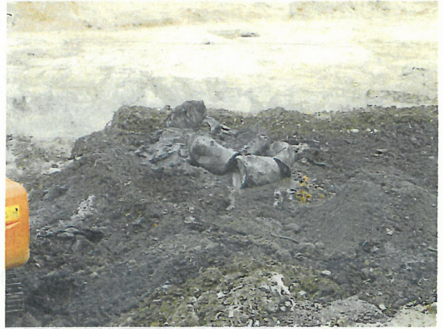
写真 4 C地点で掘削されたドラム缶
