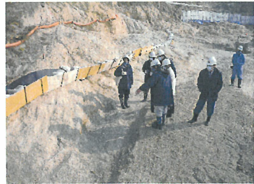
写真 4 掘削完了判定調査(H23.12.15)
