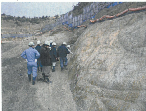
写真 1 掘削完了判定調査(H23.12.15)
