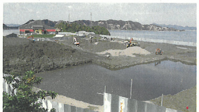
写真2 トレンチ拡幅及び混合面の復旧状況
