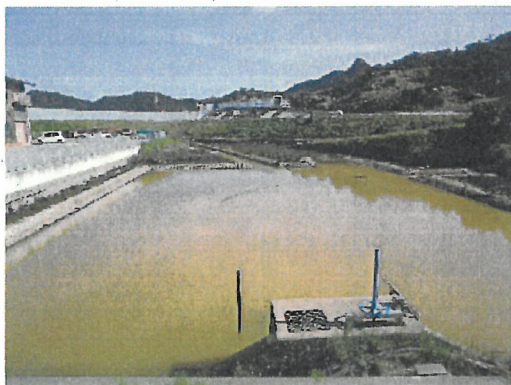
写真 沈砂池 1 の状況(平成 23 年 11 月 11 日)
