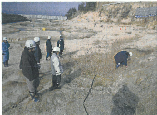
写真 3 掘削完了判定調査(H23.12.15)
