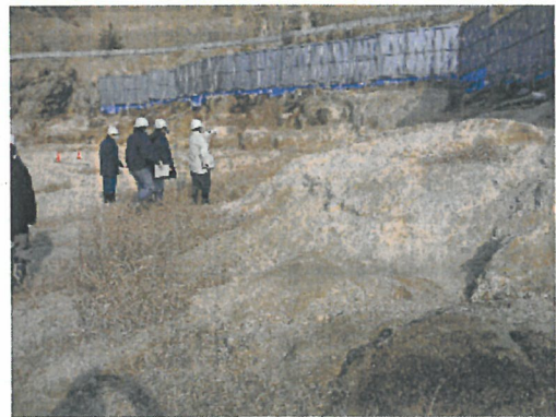
写真 2 掘削完了判定調査(H23.12.15)
