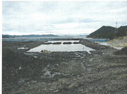
北及び南東トレンチ
