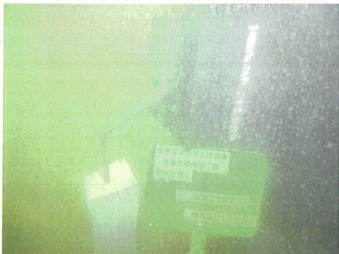
電気防食施工完了状況
