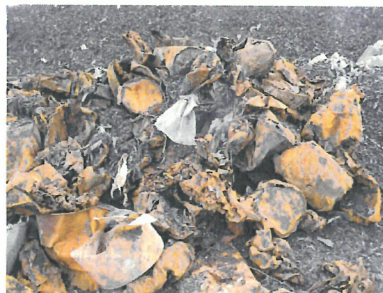
写真4 掘削されたドラム缶
