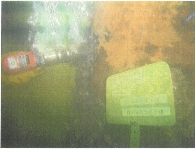
鋼板巻立前処理（かき落とし）状況
