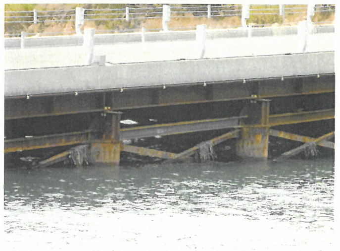
鋼材補修施工完了状況（H鋼取替え）
