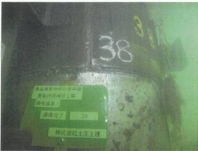
鋼板巻立施工完了状況
