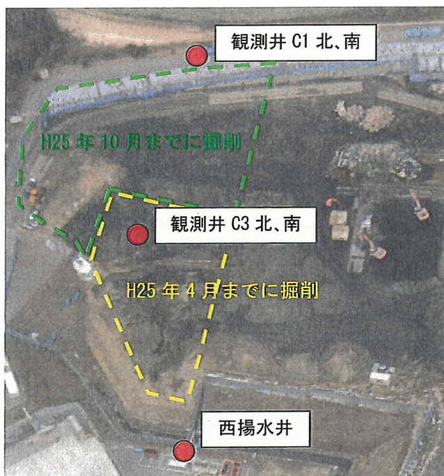
図 1 処分地 D 測線西側
