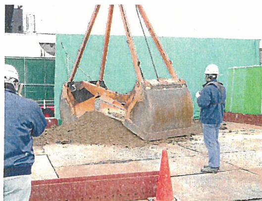
輸送船クレーンでの輸送船への積み込み
