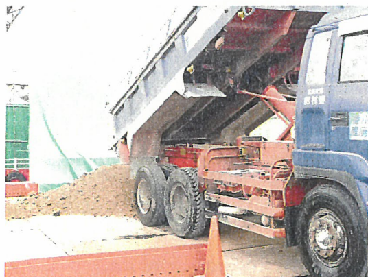
ダンプから積み込みヤードへの積下ろし
