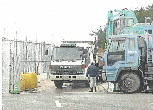
ダンプへの積み込み
