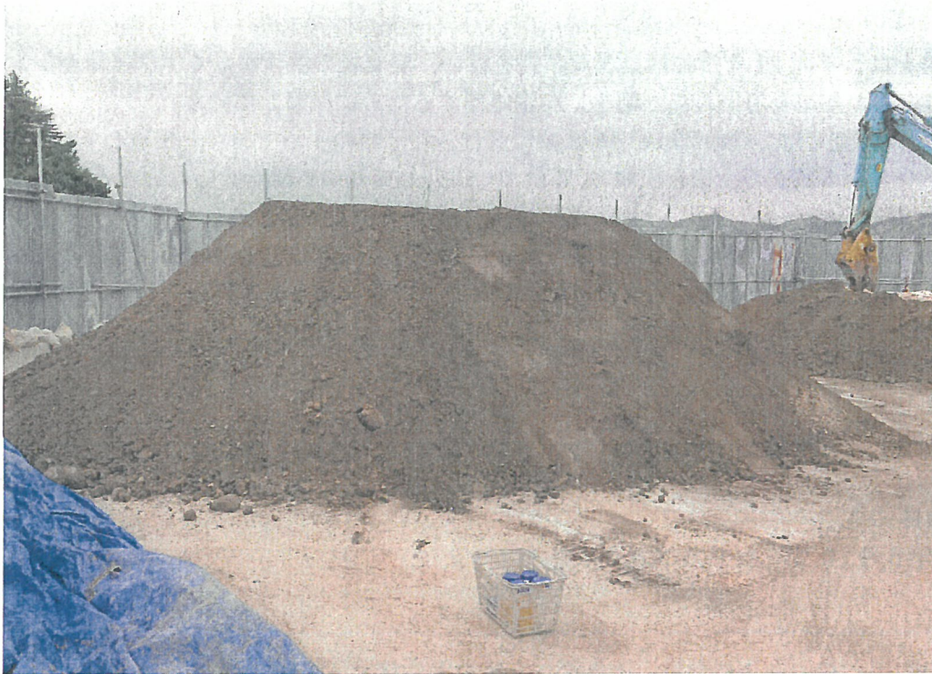
写真 平成 24 年 5 月 30 日に試料採取したロット1
