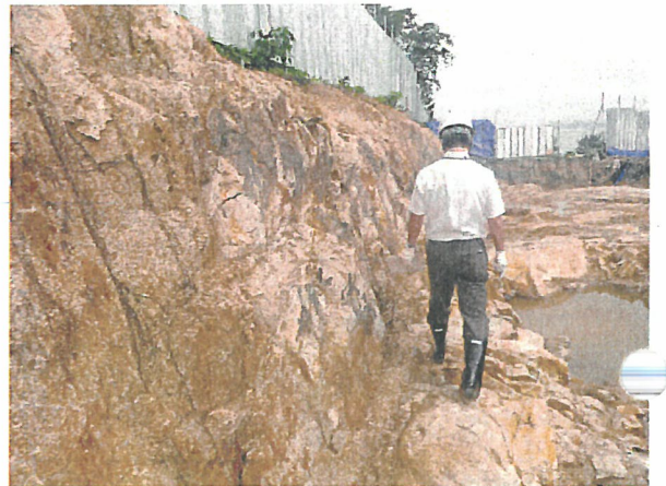
写真2 掘削完了判定調査 (H25. 6. 27)
