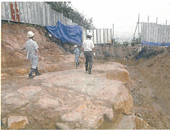
写真1 掘削完了判定調査 (H25. 6. 27)
