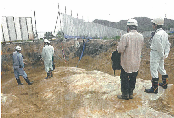
写真3 掘削完了判定調査の立会い状況 (H25. 6. 27)
