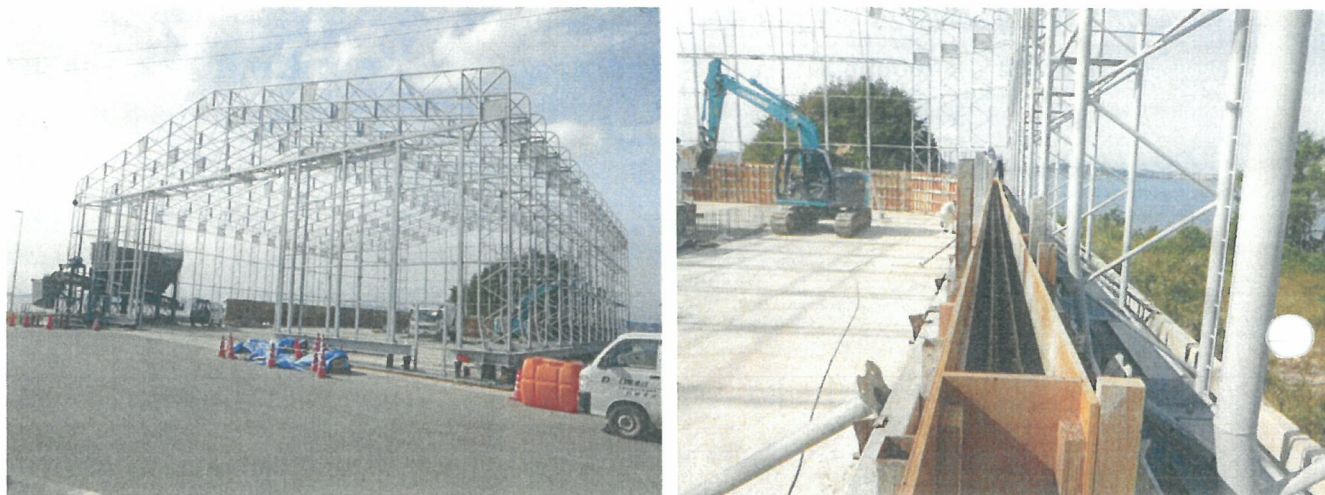
写真 仮設テント施工状況(施工中)
