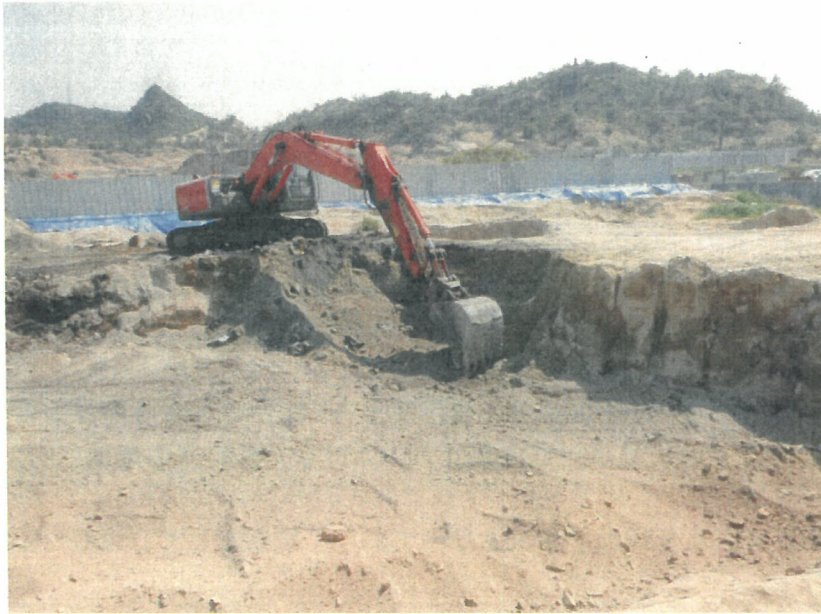
9月23日の掘削状況
