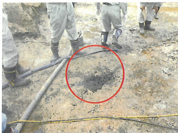
写真3 掘削完了判定等の様子 (H26. 7. 22)
