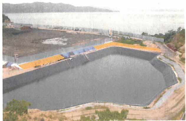
写真2 H+20 付近の底面掘削完了の確認
