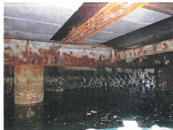
② 鋼材の表面状態
