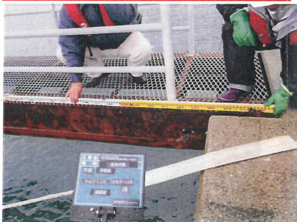
③ 鋼桁ウェブに穴開き
