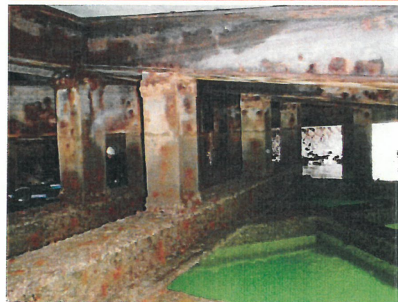
③ 鋼材の表面状態
