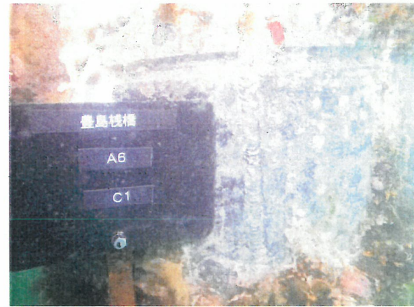
② 補修箇所の状態 (付着物を除去した鋼材表面)
