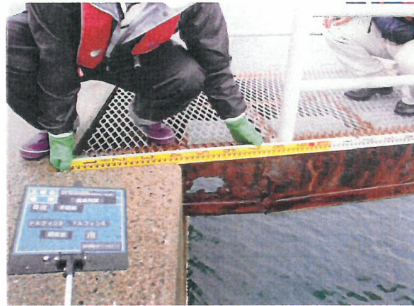
① 鋼桁ウェブに穴開き
