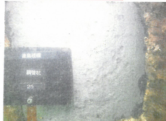
④ 付着物を除去した鋼材表面
