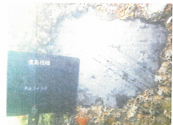
⑥ 杭No.2-1(付着物を除去した鋼材表面)
