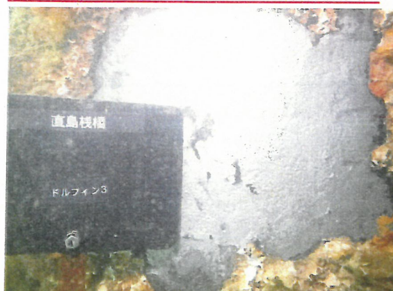
⑦ 杭No.3-1(付着物を除去した鋼材表面)
