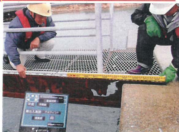
④ 鋼桁ウェブに穴開き
