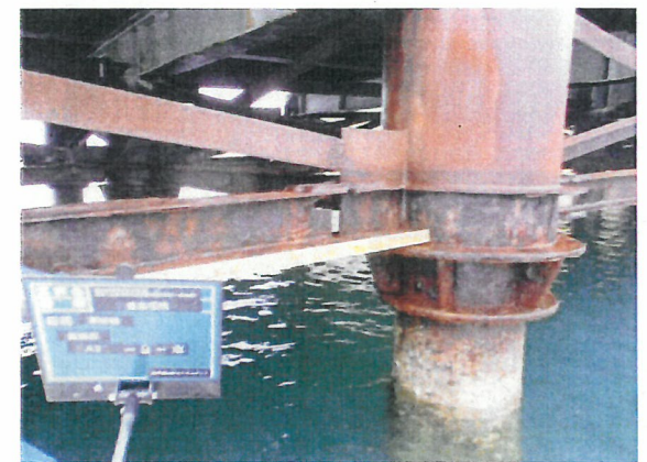
⑥ 水平継材に穴開き
