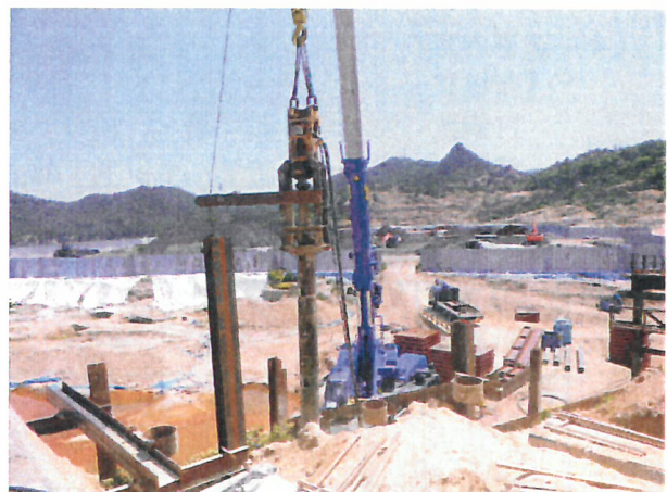
写真2 H鋼杭削孔状況
