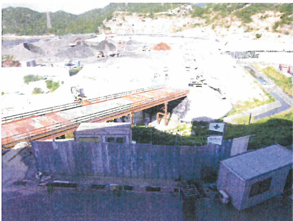
写真3 仮橋設置状況
