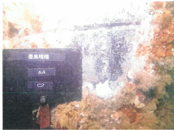
① 補修箇所の状態 (付着物を除去した鋼材表面)
