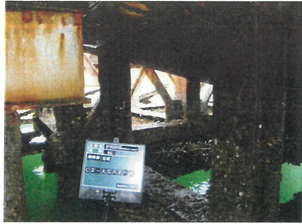
① 鋼材の表面状態
