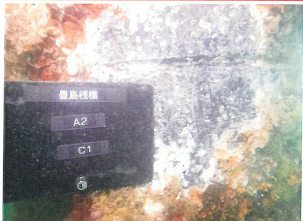
④ 補修箇所の状態 (付着物を除去した鋼材表面)
