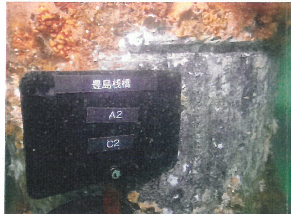
③ 補修箇所の状態 (付着物を除去した鋼材表面)
