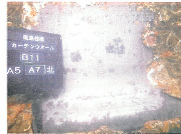
⑤ 鋼材の表面状態 (付着物除去)
