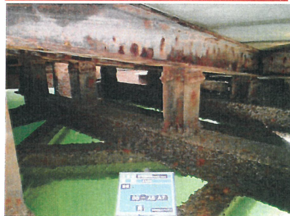
④ 鋼材の表面状態
