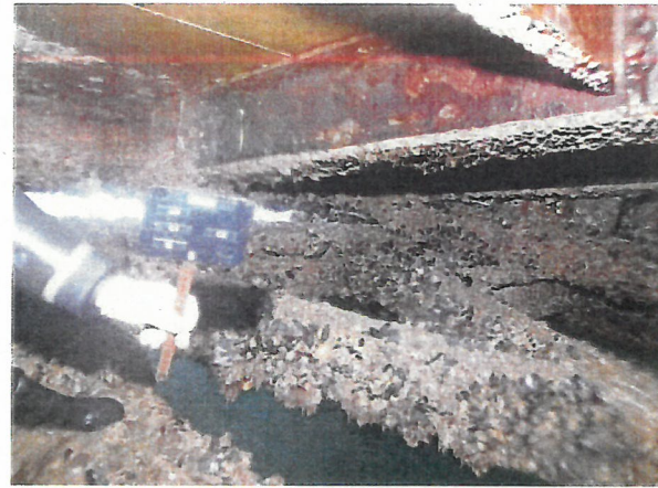
② 鋼材の表面状態
