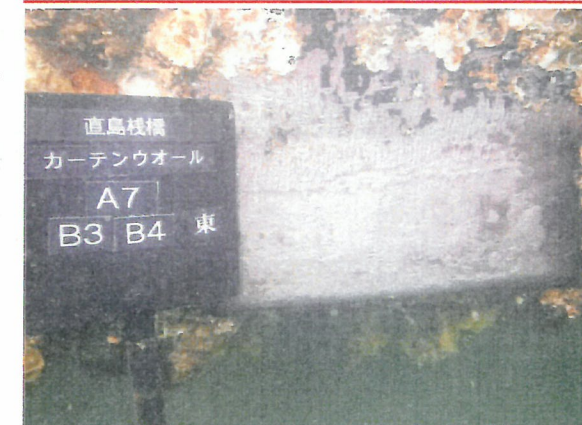
⑥ 鋼材の表面状態 (付着物除去)
