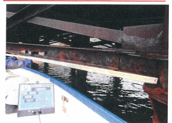
⑧ 水平継材に穴開き
