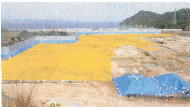
写真1 (E-F, 3-4)、(F-G, 3-4)、(F-G, 2-3) 及び (G-H, 1-2) 付近の底面掘削完了の確認
