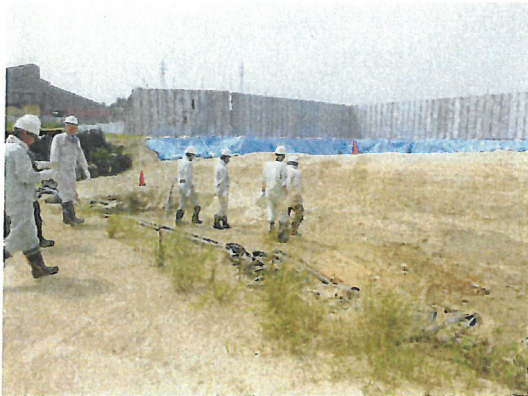
写真4 掘削完了判定の様子 (H27.7.29)
