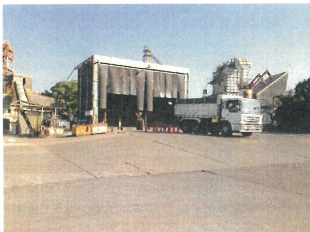
③豊島汚染土壌置場からダンプでホッパーへ投入
