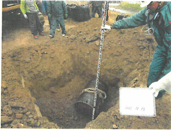
写真-4 深度 1.8m におけるドラム缶埋設状況
