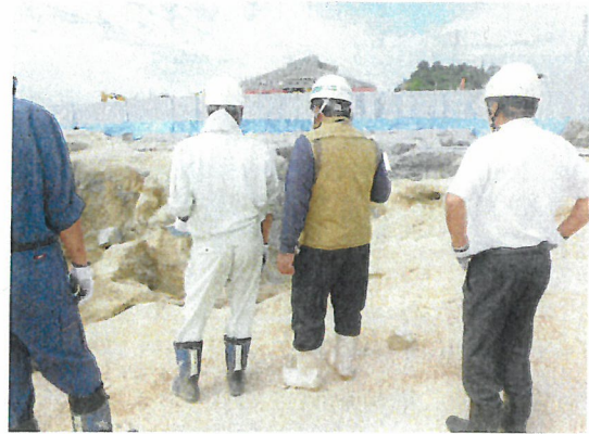
写真5 底面掘削完了確認の様子 (H27.9.30)
