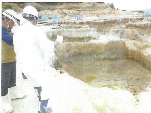
写真8 掘削完了判定の様子 (H27.9.30)
