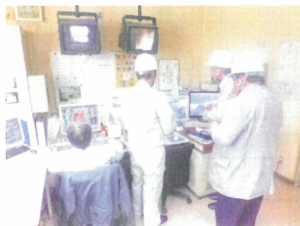
⑤中央制御室での運転状況（燃焼ガス温度等）確認
