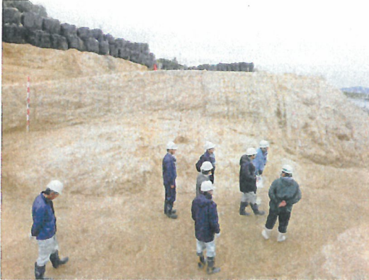
写真10 掘削完了判定の様子（H27.11.25）
