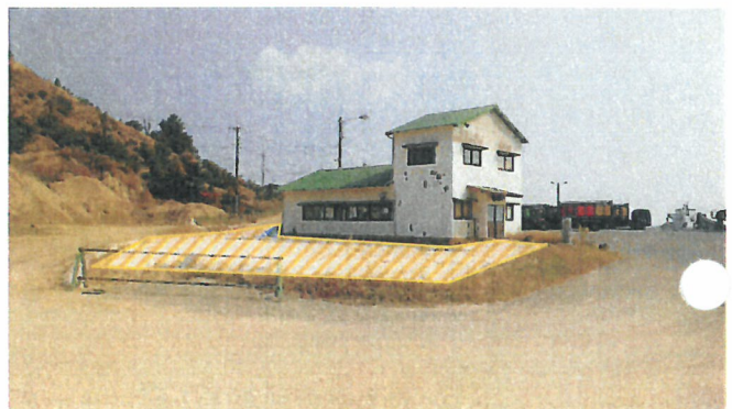
写真2 「こころの資料館」周辺の廃棄物等除去確認
