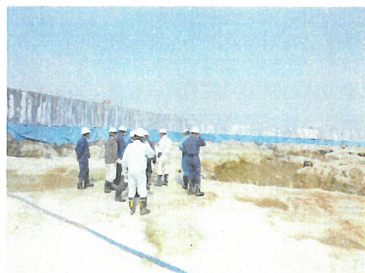
写真9 底面掘削完了確認の様子 (H27.10.30)
