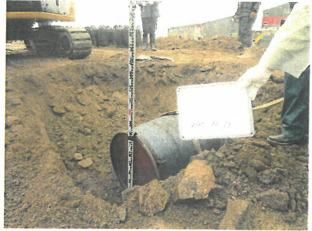
写真-5 深度 1.0m におけるドラム缶埋設状況
