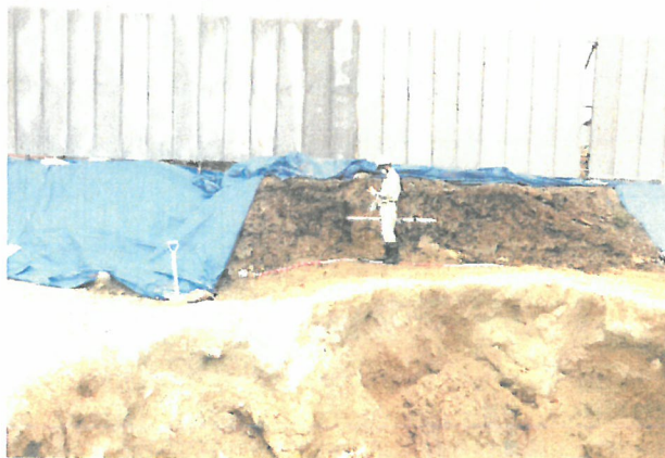
写真-3 検証①地点の測定状況
