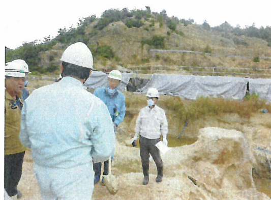
写真7 底面掘削完了確認の様子 (H27.9.30)
