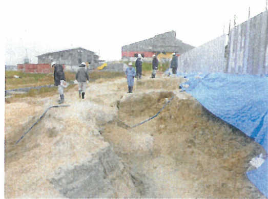
写真11 底面掘削完了確認の様子（H27.11.25）
