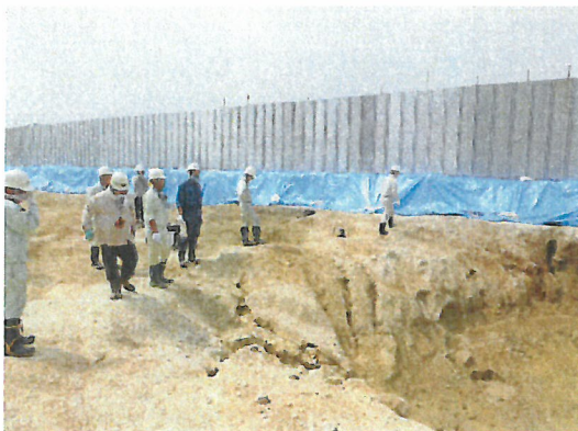
写真6 掘削完了判定の様子 (H27.7.29)
