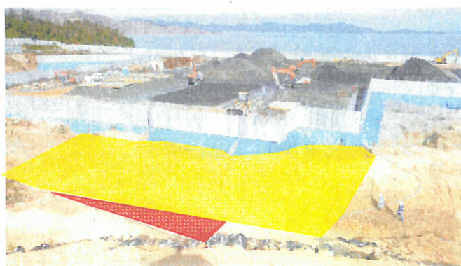
写真3 (E, 4) 付近の掘削完了判定等の実施
