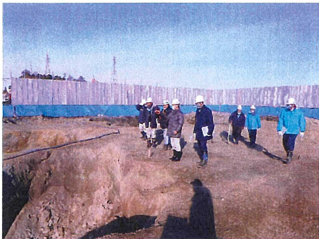
写真5 底面掘削完了確認の様子 (H28. 1. 22)
