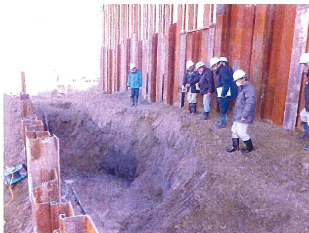
写真7 底面掘削完了確認の様子 (H28. 1. 22)
