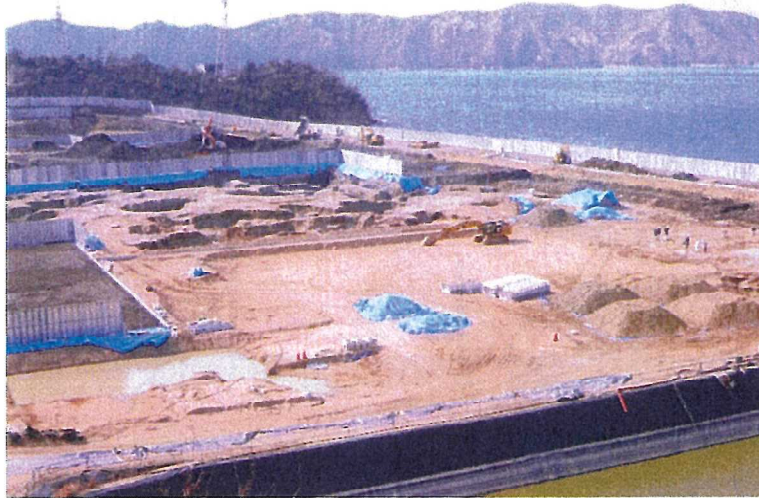
写真3 廃棄物仮置きヤード及び廃棄物搬入路の施工状況
