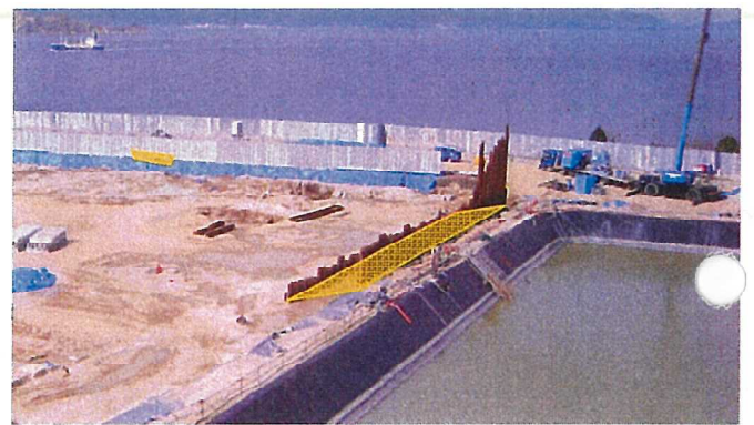
写真2 (H+15, 2) 付近の底面掘削完了の確認
