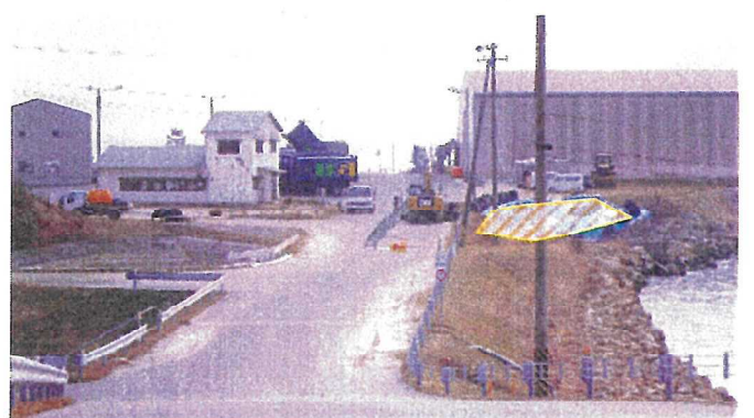
写真4 西海岸の黒色物質除去の確認
