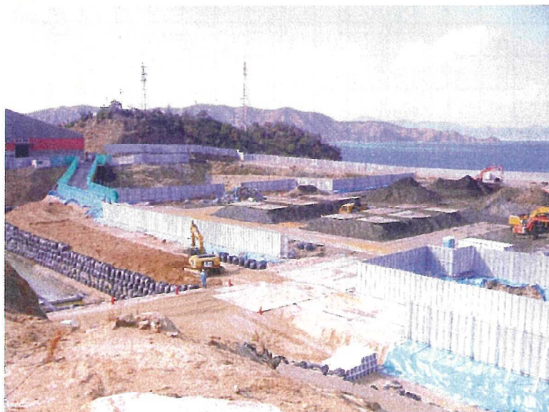
写真2 搬出道路の施工状況
