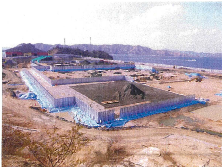
写真1 最終混合面の施工状況
