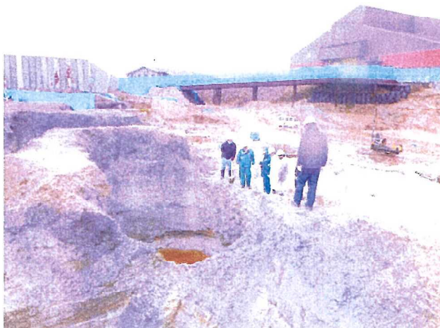
写真8 底面掘削完了確認の様子 (H28. 2. 29)
