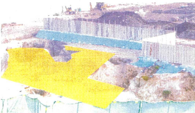
写真3 (C-D, 2-3) 付近の底面掘削完了の確認
