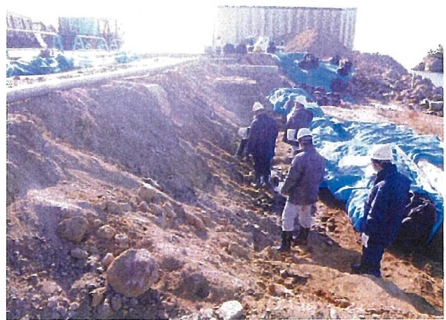
写真9 黒色物質撤去確認の様子 (H28.1.22)
