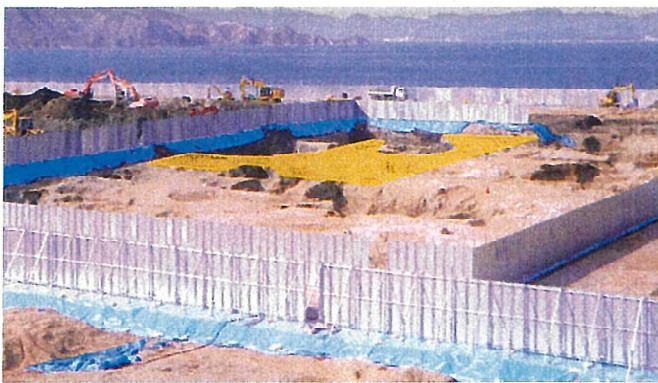
写真1 (E-F, 2-3) 付近の底面掘削完了の確認
