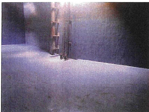
写真1 第1槽（流入槽） 清掃後
