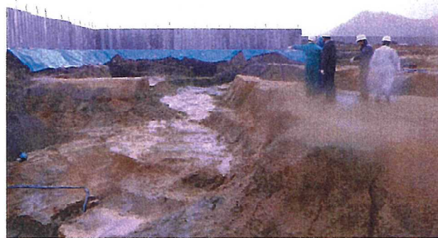
写真6 底面掘削完了確認の様子 (H28. 2. 29)
