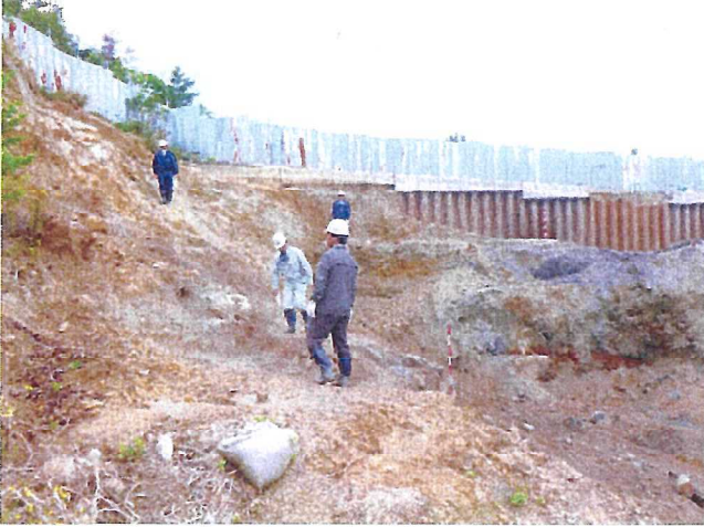
写真3 掘削完了判定の様子 (H28. 4. 28)
