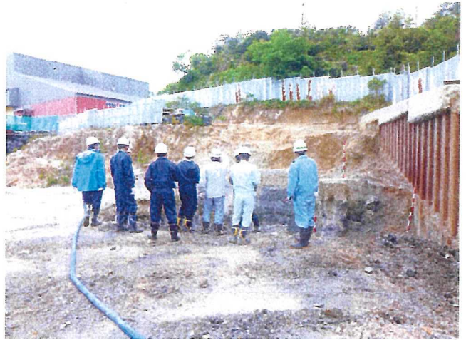
写真4 底面掘削完了確認の様子 (H28. 4. 28)
