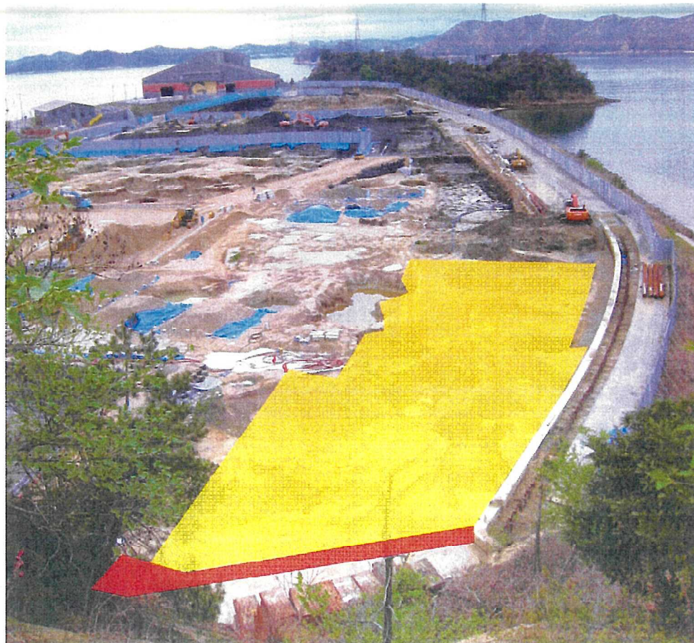
写真1 (H-I, 1) 付近の掘削完了判定等の実施
