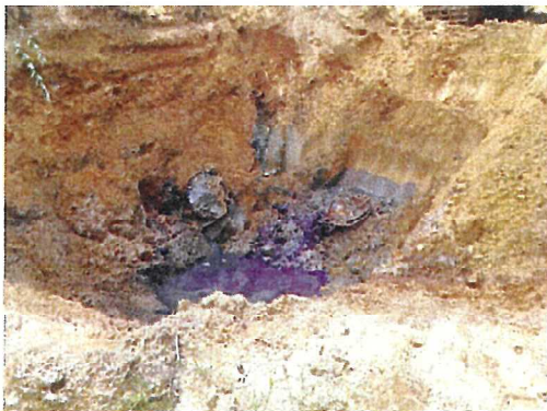
写真4 ドラム缶埋設状況
