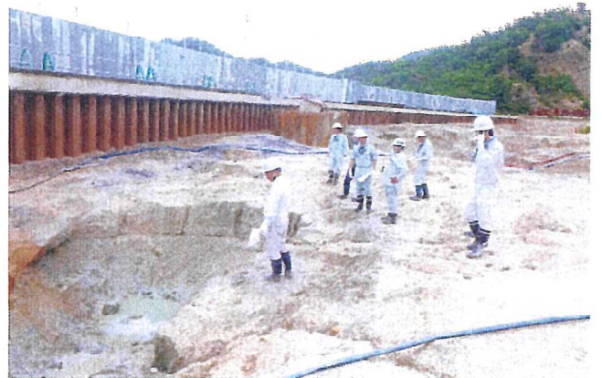
写真5 底面掘削完了確認の様子 (H28. 5. 27)
