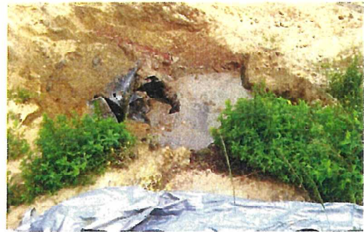
写真3 ドラム缶埋設状況
