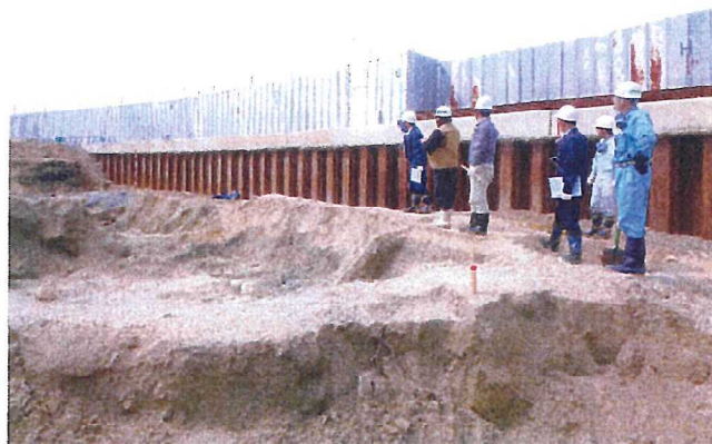
写真3 底面掘削完了確認の様子（H28.4.8）
