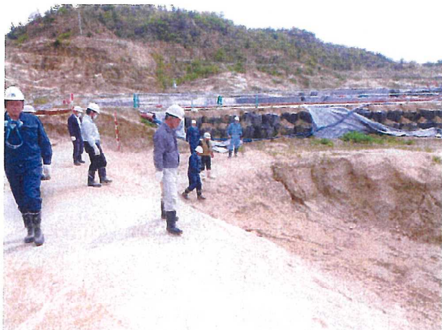
写真2 掘削完了判定の様子（H28.4.8）
