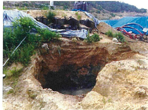
写真5 掘削除去後（たまり水は湧水）
