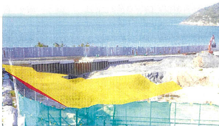
写真1 (B-C, 2) 付近の掘削完了判定等の実施
