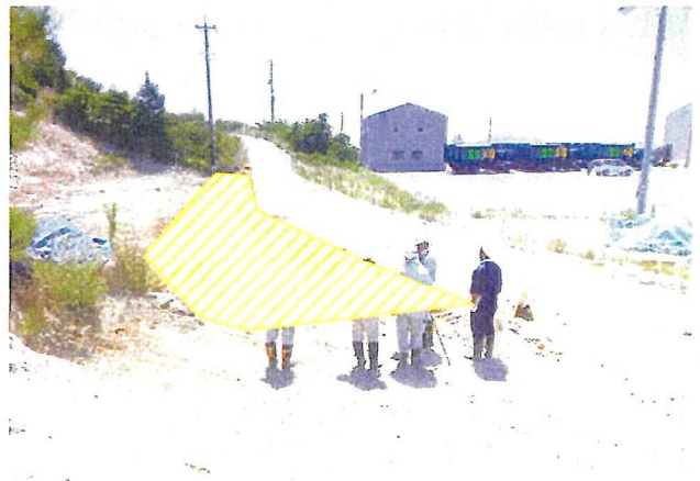
写真4 進入路下の黒色物質除去確認
