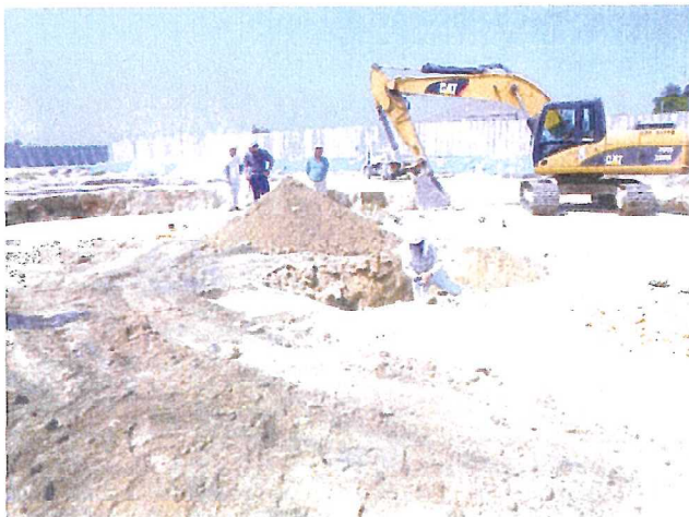
写真 28 再探査実施状況 (②)
