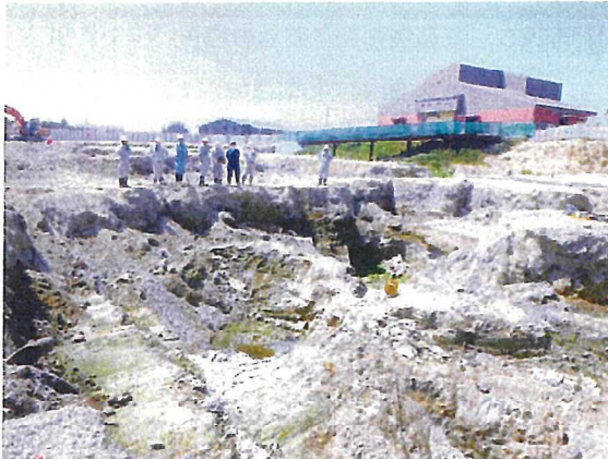
写真14 底面掘削完了確認の様子 (H28. 8. 8)
