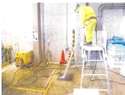
写真1 高圧洗浄実施中
