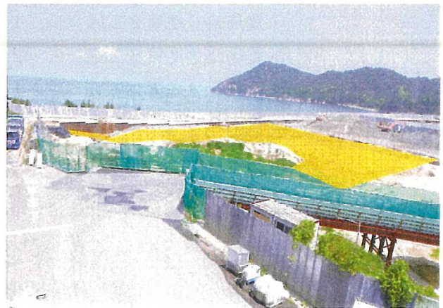
写真2 (C, 2) 及び (D, 1-3) 付近の底面掘削完了の確認
