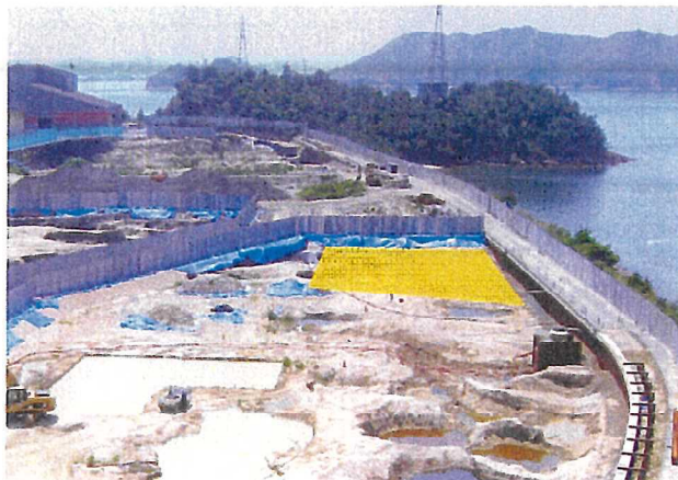
写真1 (F, 1) 付近の底面掘削完了の確認
