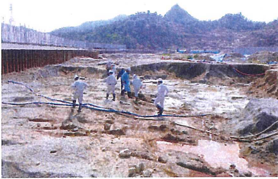
写真5 底面掘削完了確認の様子 (H28. 7. 6)
