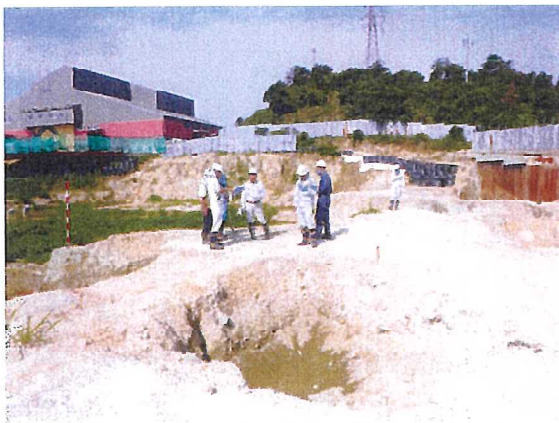
写真7 底面掘削完了確認の様子 (H28. 7. 6)
