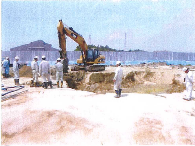
写真 25 BH 掘削確認の様子 (④)
