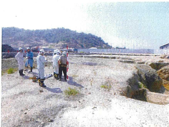
写真11 底面掘削完了確認の様子 (H28. 7. 6)
