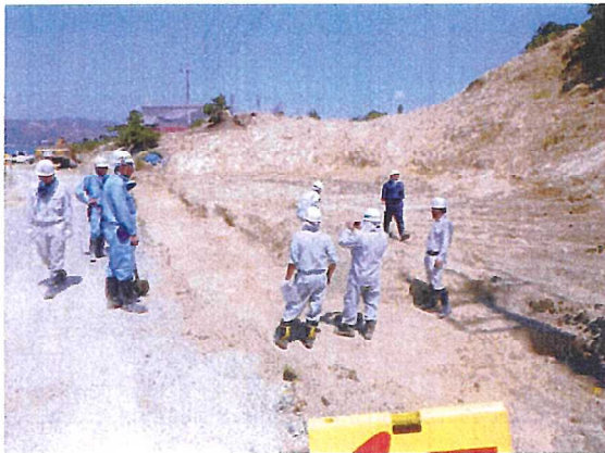
写真18 黒色物質除去確認の様子 (H28.8.8)
