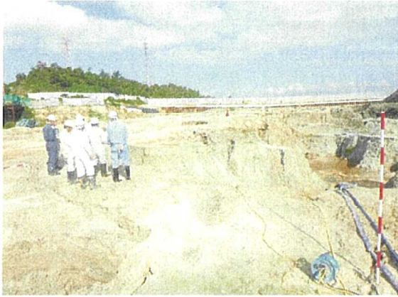
写真6 底面掘削完了確認の様子 (H28.9.27)
