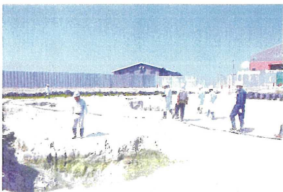
写真15 底面掘削完了確認の様子 (H28. 7. 6)
