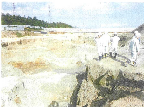
写真2 底面掘削完了確認の様子 (H28.9.27)
