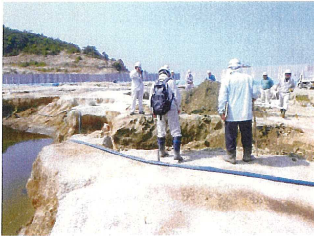
写真 19 BH 掘削確認の様子 (①)
