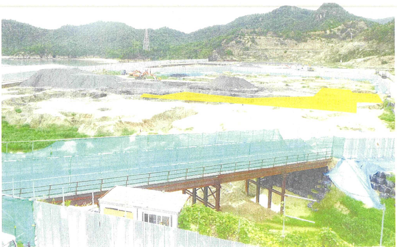
写真1 (D-E, 2-4) 付近の底面掘削完了の確認
