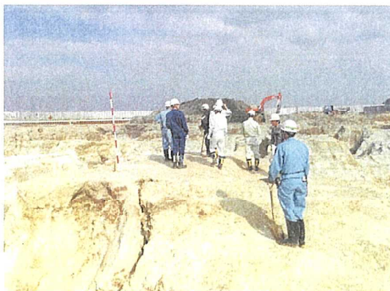
写真 39 底面掘削完了確認の様子 (H28. 11. 11)
