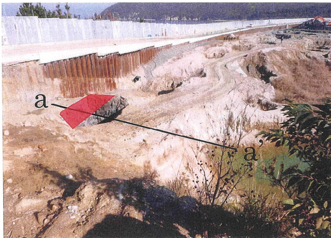
写真1 平成28年12月16日の掘削状況
