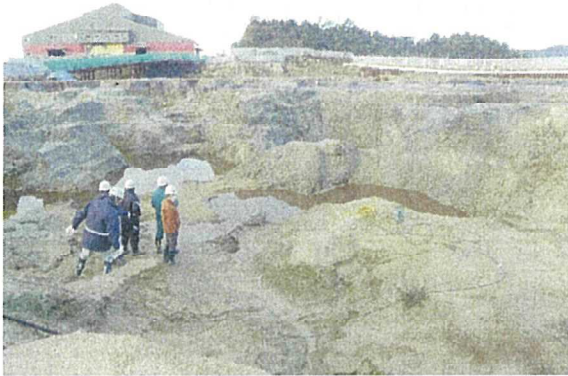
写真7 底面掘削完了確認の様子 (H28.12.15)
