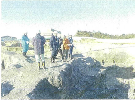
写真 19 底面掘削完了確認の様子 (H29.1.17)
