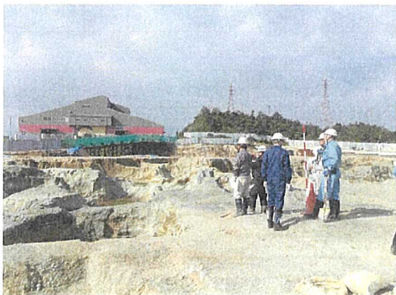
写真2 底面掘削完了確認の様子 (H28. 11. 11)
