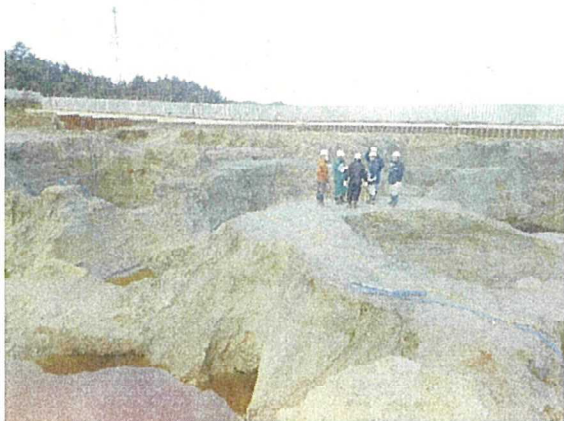
写真 20 底面掘削完了確認の様子 (H28.12.15)
