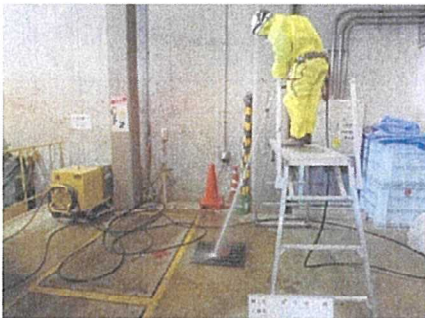
写真1 高圧洗浄実施中
