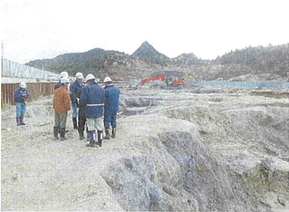
写真 13 底面掘削完了確認の様子 (H29. 1. 6)
