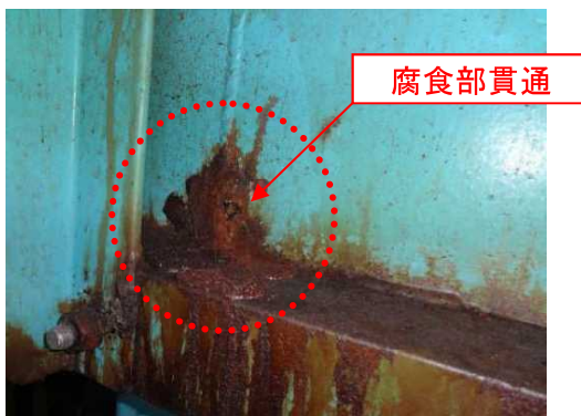
写真3. 鋼板製水槽の内面
