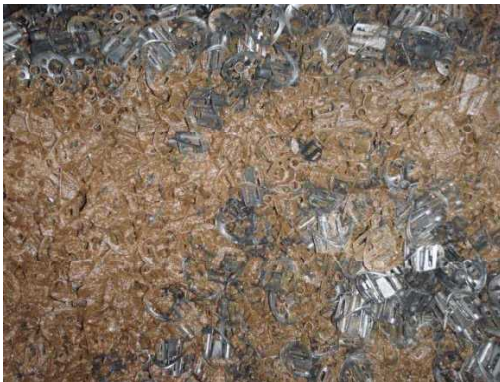
※参考写真: 脱窒槽充填材の閉塞状況 (H22 年度清掃時の写真)
