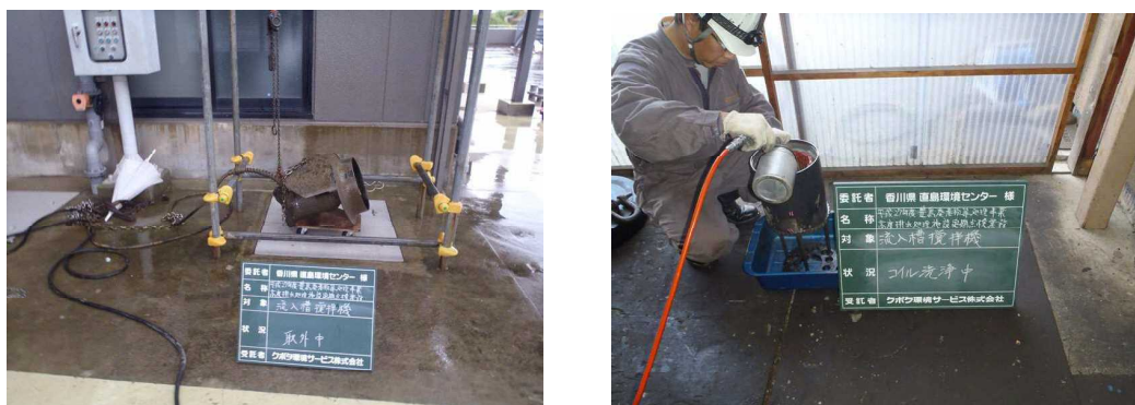
写真 2. 流入槽攪拌機整備状況（平成 27 年度）
