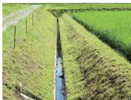
けい畔法面のカバープランツ植栽
