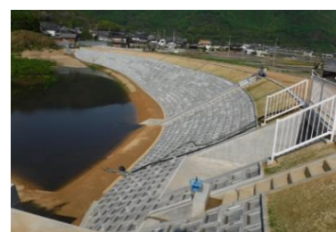
老朽対策後のため池
