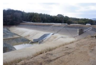
耐震対策後のため池
