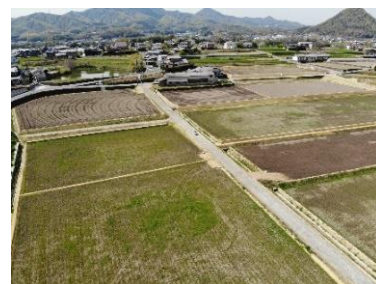
整備後のほ場
