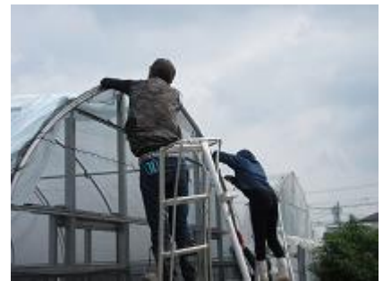
ハウス自力施工研修
