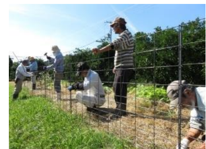
侵入防止柵の設置
