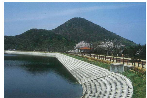
老朽ため池の改修(三郎池地区)
