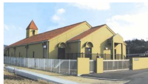
農業集落排水処理施設(丸亀市三谷地区)
