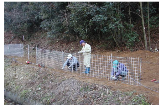
鳥獣害対策・侵入防止策の設置
