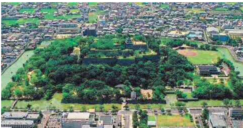
▲亀山公園の全景
