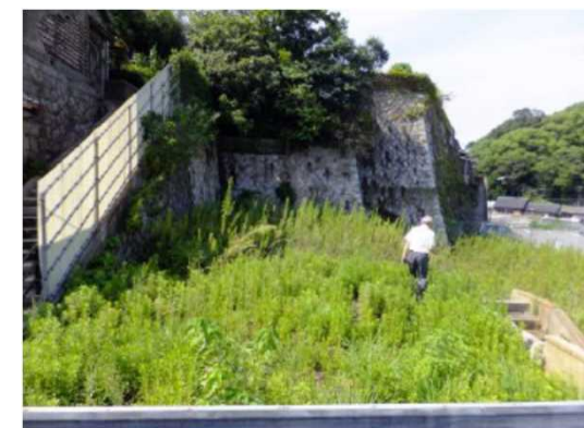
雑木が繁茂している例（イメージ） （出典）国土交通省「空き地等の新たな活用に関する検討会」資料
