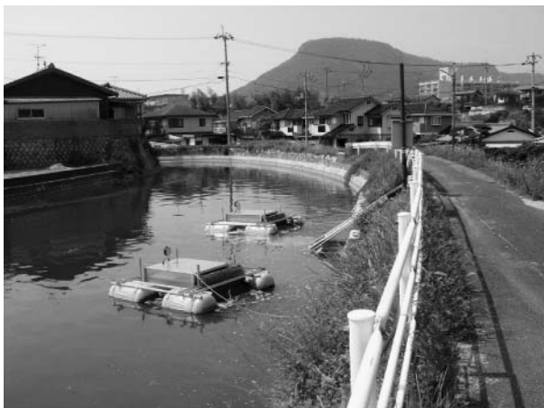
写真1 水質浄化機器の設置状況 (平成17年9月2日撮影)
