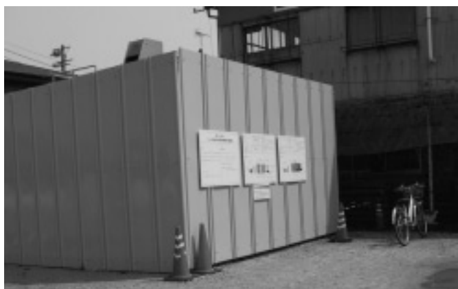
写真1 性能試験実施場所
