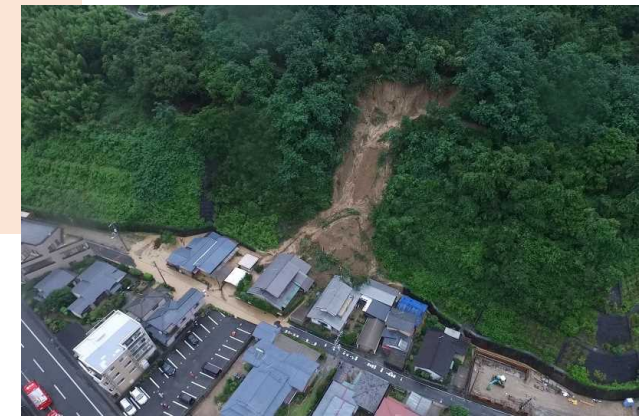
西日本豪雨による土砂災害(屋島西町地区) (平成30年7月)
