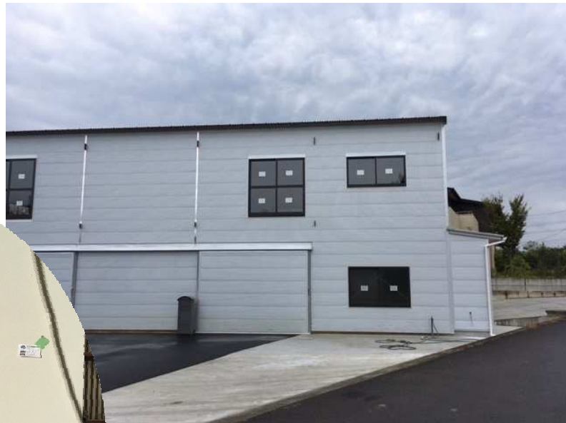
建設中の作業場兼社屋
