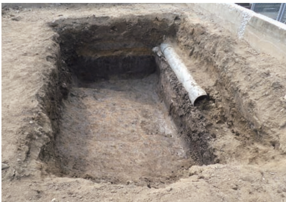
写真3 SD01 完掘状況 (東より)
