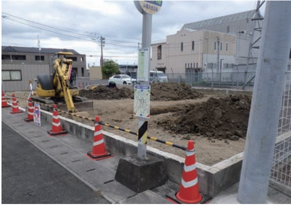
写真1 調査地近景 (南東より)
