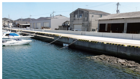
▲地震・津波対策工事(志度港)
