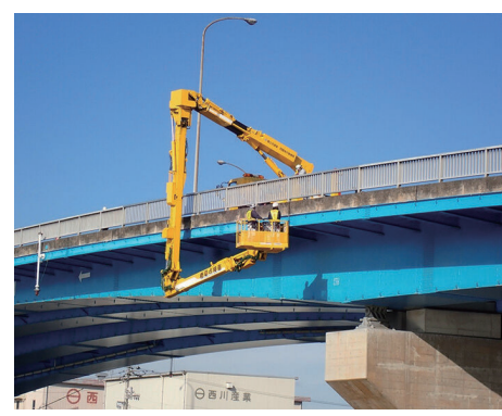
▲橋梁点検 (県道大屋富築港宇多津線(両景橋))
