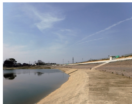
▲ため池の耐震補強工事
