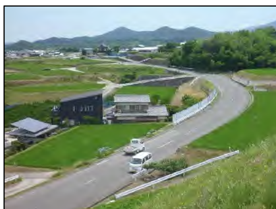
豊浜工区供用開始区間
