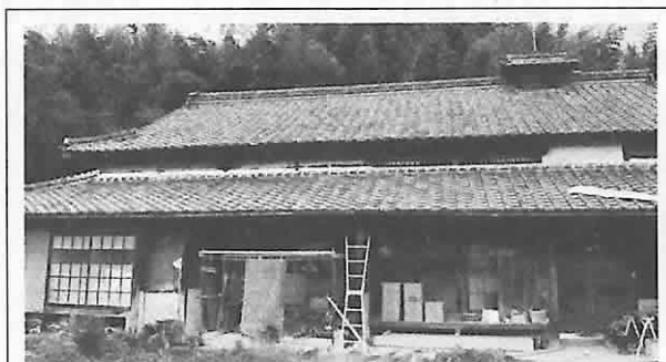
写真2 母屋(平成27年12月撮影)
