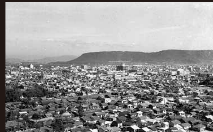
竣工当時の香川県庁舎(中央)と高松市街地[1958年]/所蔵:香川県
