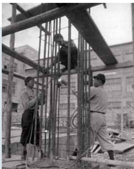
鉄筋の組み上げ [1956年]
