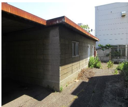
外観 5（北側倉庫東側）
