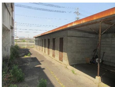
外観 4（北側倉庫西側）
