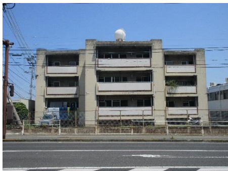
外観 1（南側建物）
