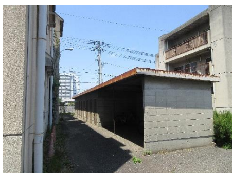
外観 3（南側倉庫）
