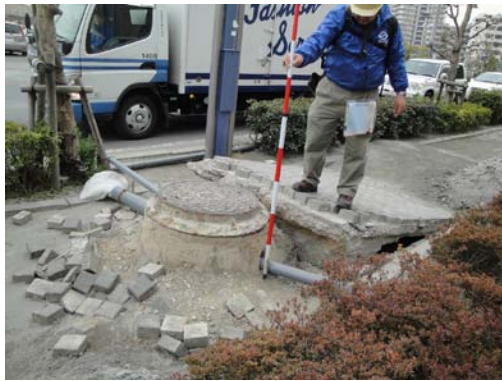
図1 液状化によるマンホールの浮き上がり（浦安市）
