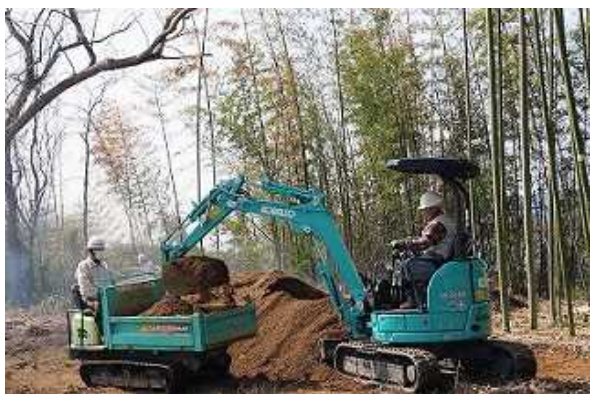
コミセン前所長の操作で土砂を積み込み
