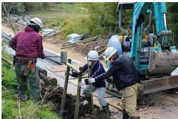
支柱のくい打ち
