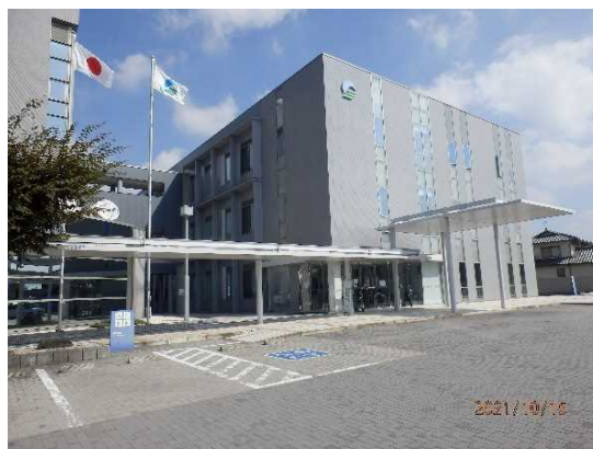
本庁舎に隣接した危機管理センター 2階の廊下で繋がっております
