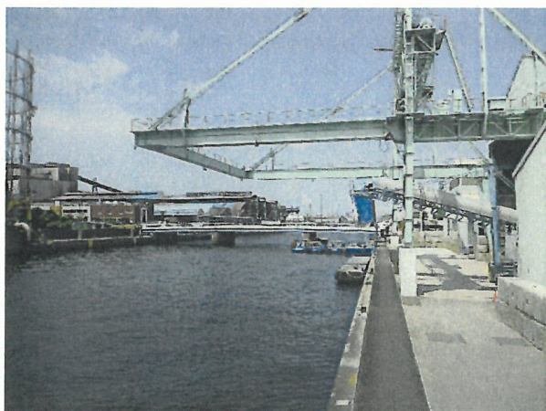
写真2 荷下ろし施設の現況写真(平成 23 年 7 月 26 日撮影)
