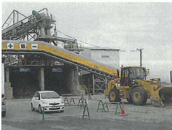
写真1 水洗浄処理施設の現況写真(平成 23 年 7 月 25 日撮影)
