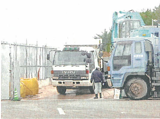
ダンプへの積み込み
