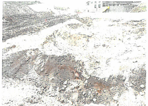
写真3 C3 地点より南側の掘削状況
