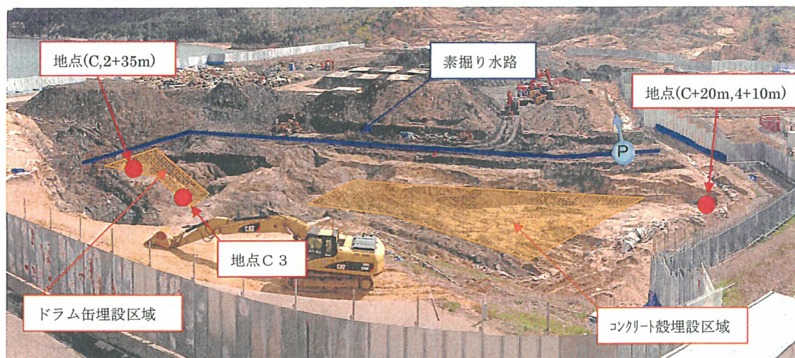
写真1 底面掘削の状況
