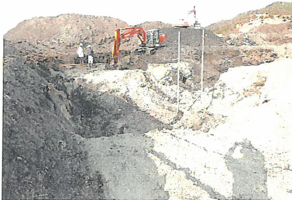
写真2 C3 地点より北側の掘削状況
