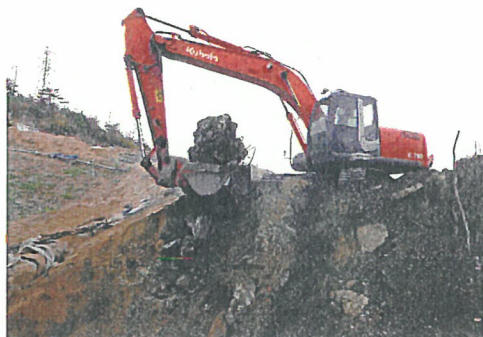
写真7 コンクリート殻の掘削状況
