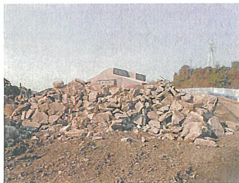
写真8 掘削されたコンクリート殻
