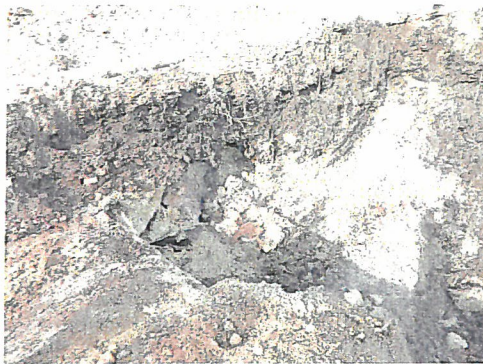
写真4 ドラム缶埋設状況
