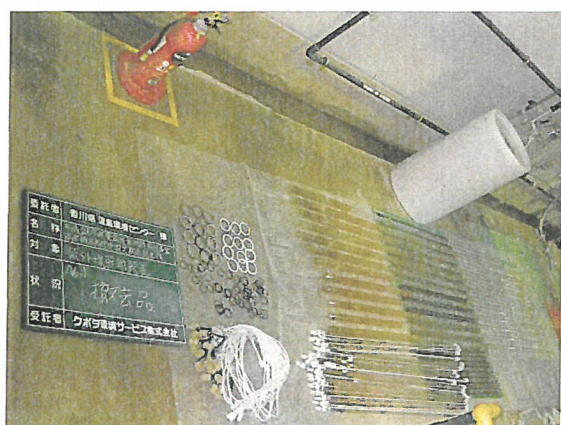
写真 4.1 石英ジャケット劣化状況
