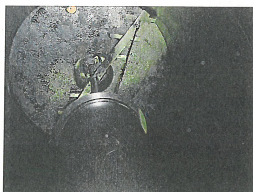
写真 2.2 槽内洗浄補修後
