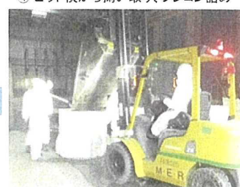
④ ピット横から掬い取り、フレコン詰め
