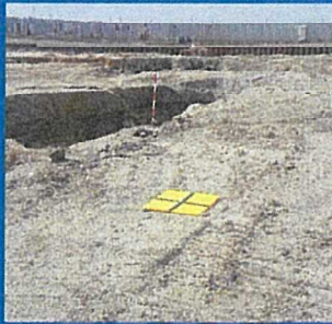
基準点設置 GPS測量(20点)
