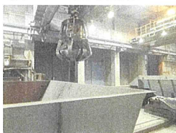
① クレーンでピットから取り出し
