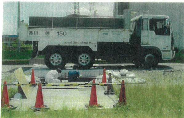
(c) たわみ量及び鉄筋ひずみの測定
