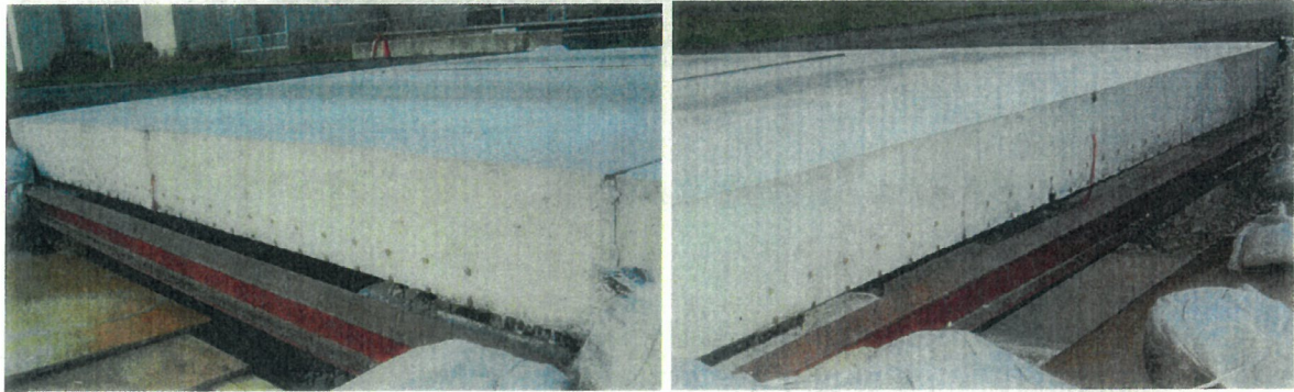
写真-1 RC 床版橋の全景とコンタクトチップ・ダイヤルゲージ設置架台の設置状況 (左：JIS コン、右：スラグコン)
