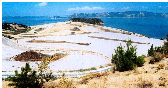
写真2-2-3-3-1 透気・遮水シートの敷設状況
