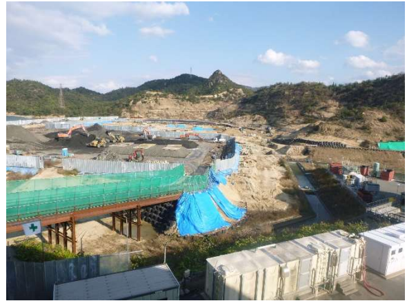
写真3-1-3-2-2 混合面設置状況（平成27年12月）
