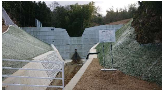
写真3-2-2-2 溶融スラグコンクリート使用事例
