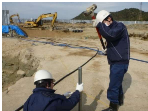
写真 3-1-2-2-4 土壌のサンプリング作業の状況
