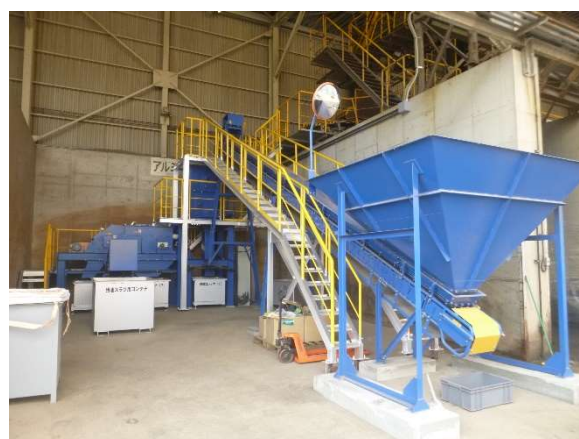
写真3-2-4-1 アルミ選別設備
