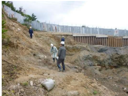
写真 3-1-2-2-3 岩盤部の掘削完了判定の状況
