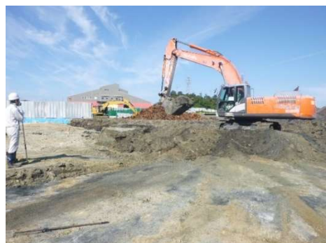
写真3-1-2-2-1 底面掘削の実施状況
