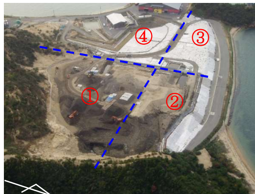
写真3-1-2-3-1 工区分け（平成17年11月撮影）
