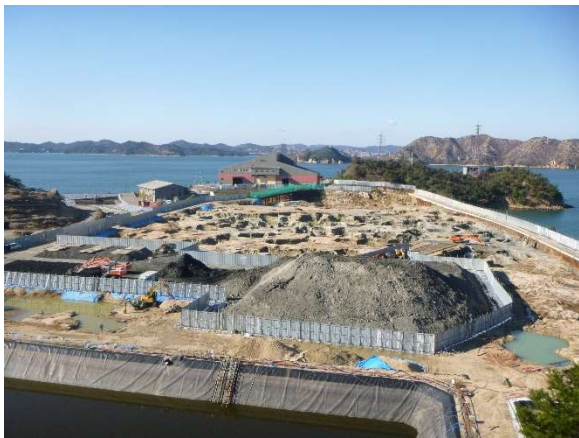
写真3-1-3-2-3 最終混合面設置状況（平成28年12月）
