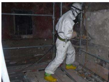
写真6-3-1-1 レベル3の保護具の着用
