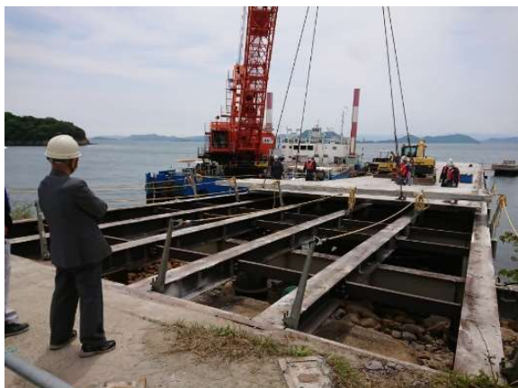
写真 6-2-3-1 床版撤去作業の確認
