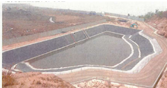
写真５－２－３－２ 貯留トレンチ
