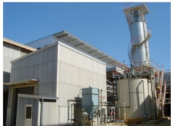
写真 7-1-2-1 溶融飛灰再資源化施設
