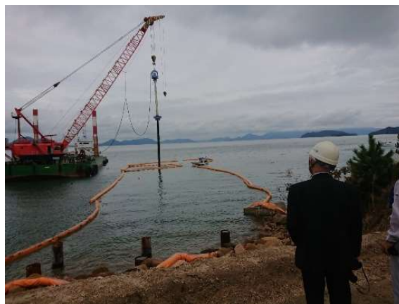
写真 6-2-3-2 鋼管杭撤去作業の確認
