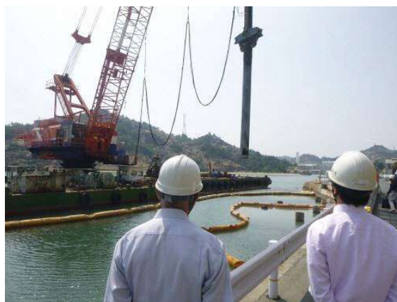
写真6-3-2-2 杭撤去作業の確認（北より撮影）
