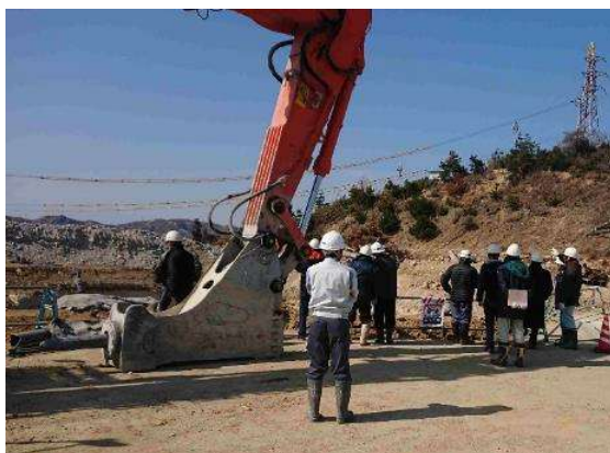
写真6-2-1-1 ピットの解体状況の確認
