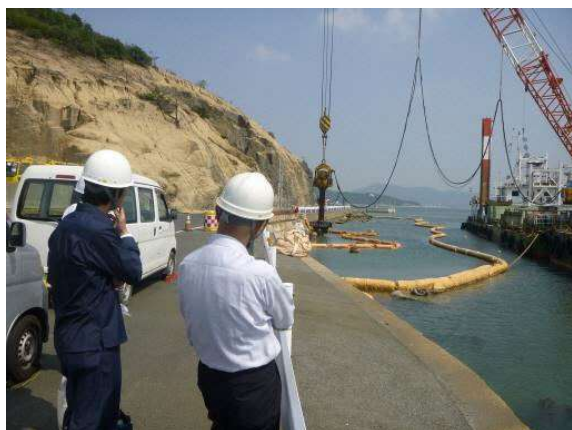
写真6-3-2-1 杭撤去作業の確認（南より撮影）
