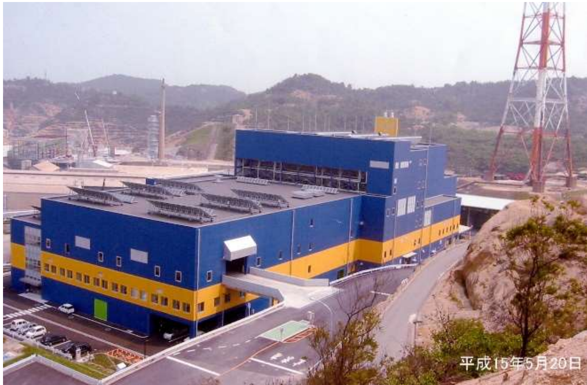
写真 10-5-32 中間処理施設 全景 1
