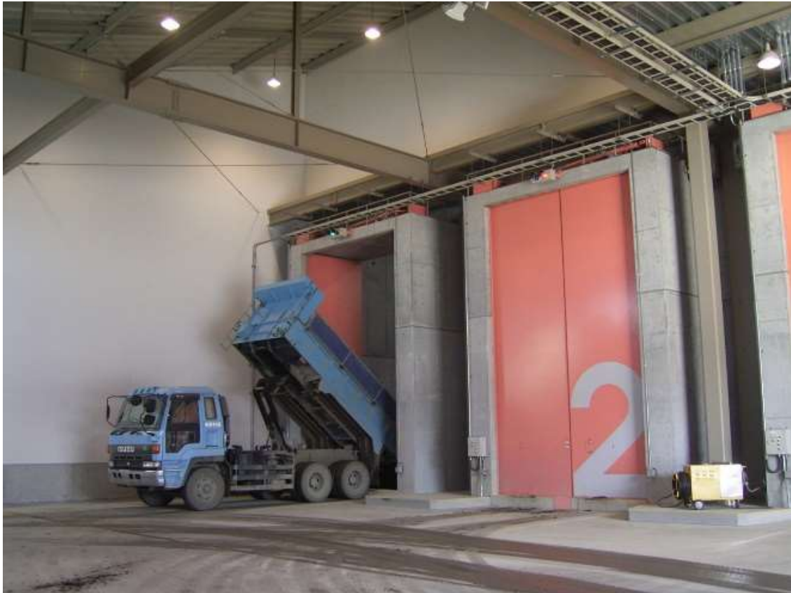
写真 10－5－20 中間保管・梱包施設 保管ピット
