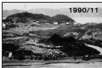
現場東部より
