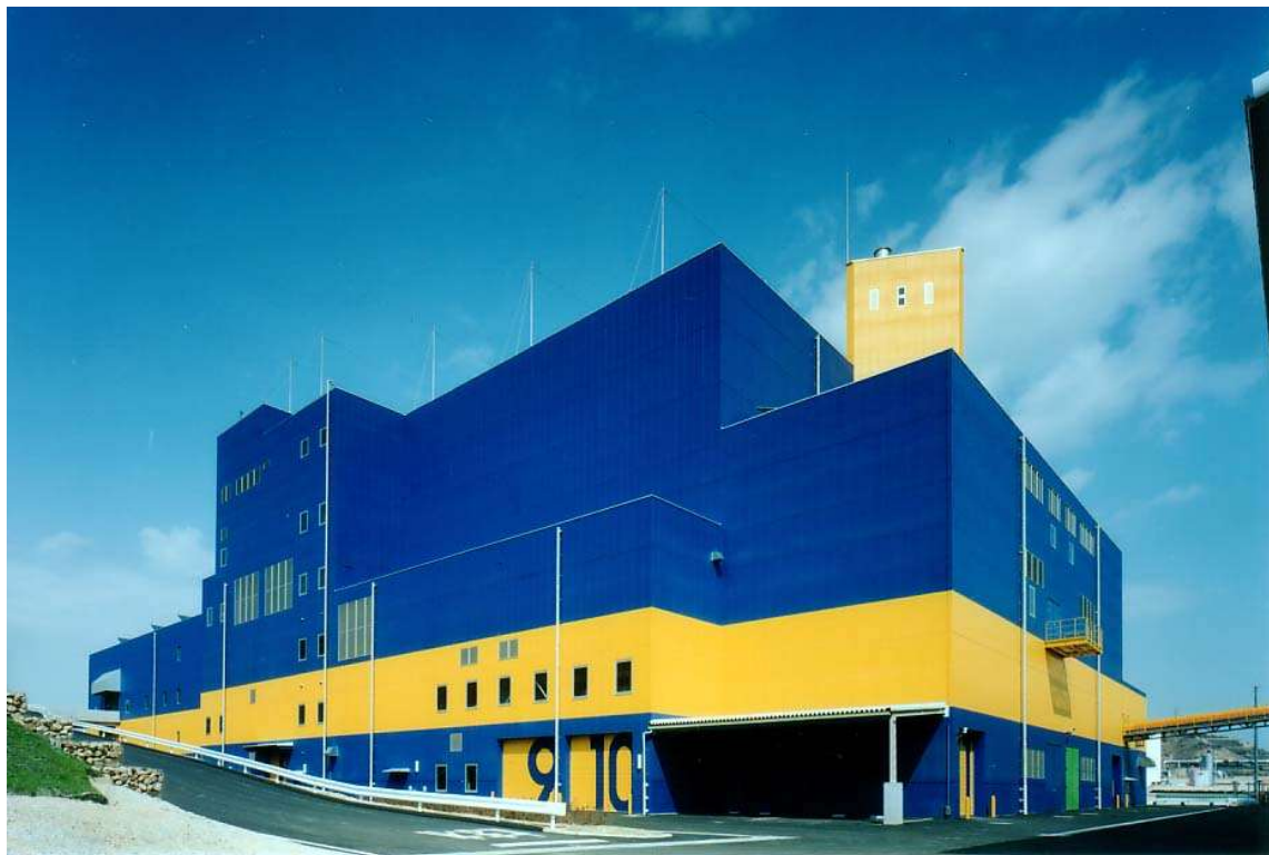
写真 10-5-33 中間処理施設 全景 2
