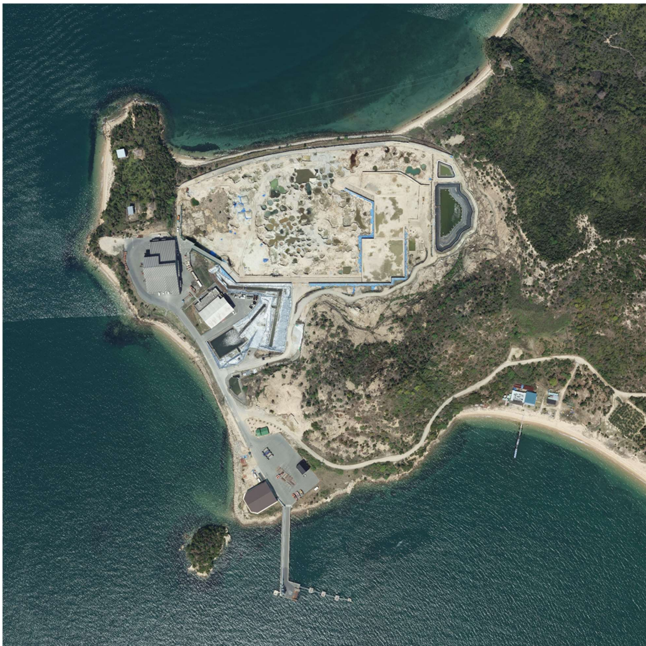
写真 10－5－15 豊島航空写真 平成 29 年 4 月（廃棄物運搬船「太陽」最終運航後）
